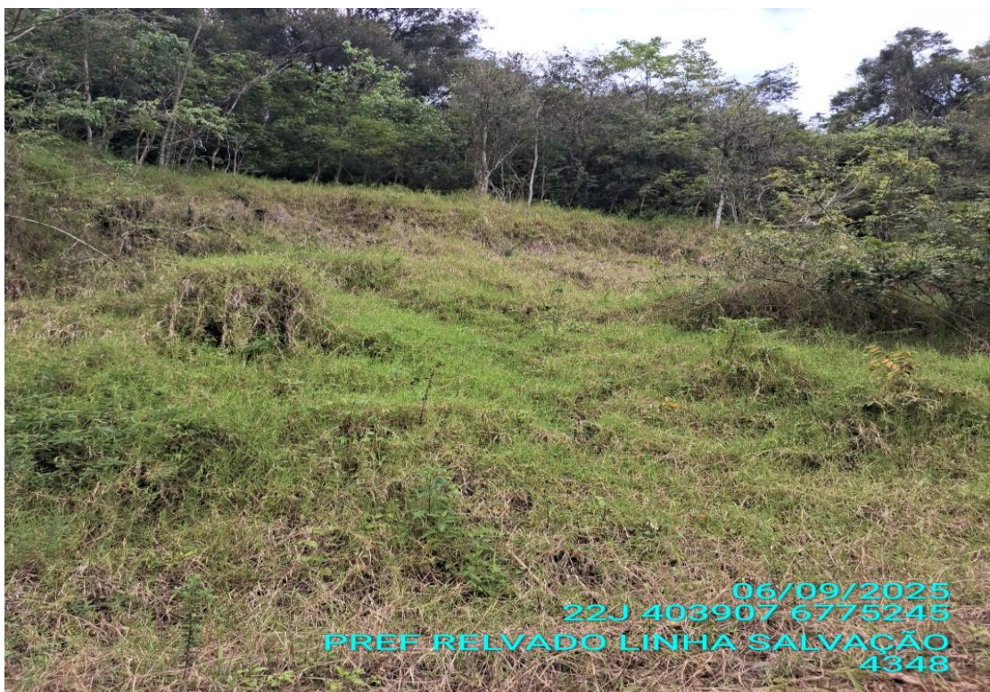
Figura 5 – Deslizamento de ocorrência anterior com a cobertura vegetal recomposta, ainda que de forma insuficiente.
