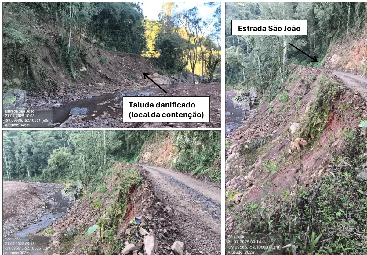
Figura 4 – Situação atual do local de instalação da contenção em Relvado
