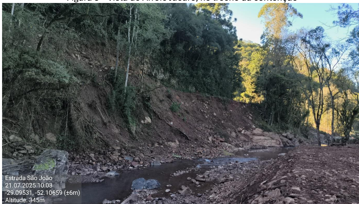
Figura 3 – Vista do Arroio Jacaré, no trecho da contenção
