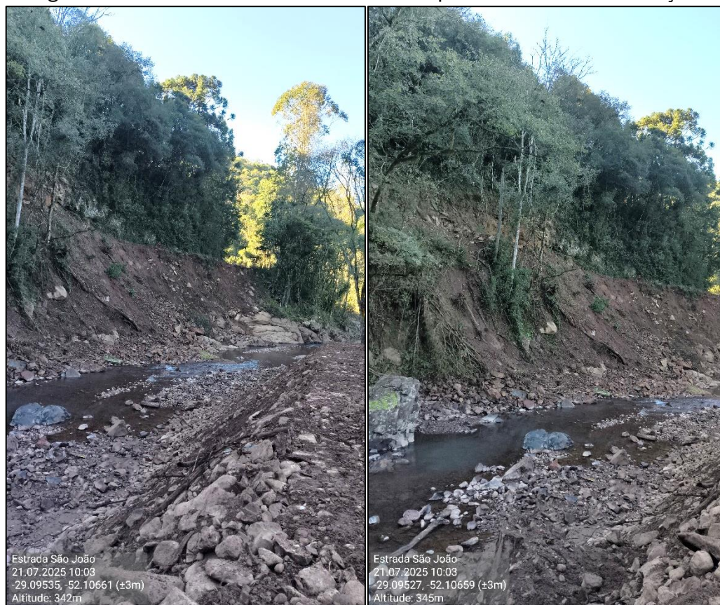
Figura 1 – Características atual do talude que irá receber a contenção
