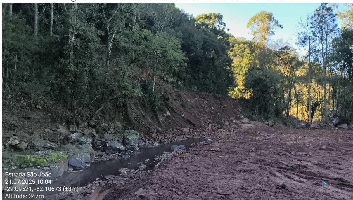
Figura 4 – Detalhes do desassoreamento do Arroio Jacaré
