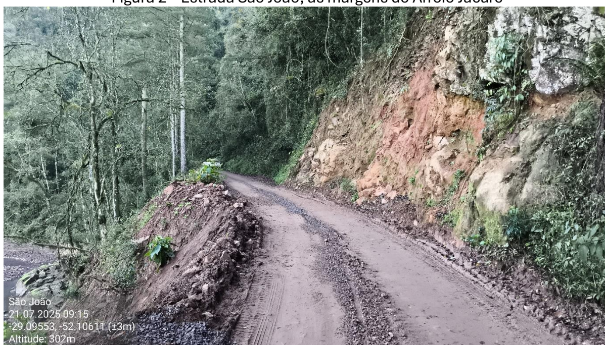
Figura 2 – Estrada São João, às margens do Arroio Jacaré
