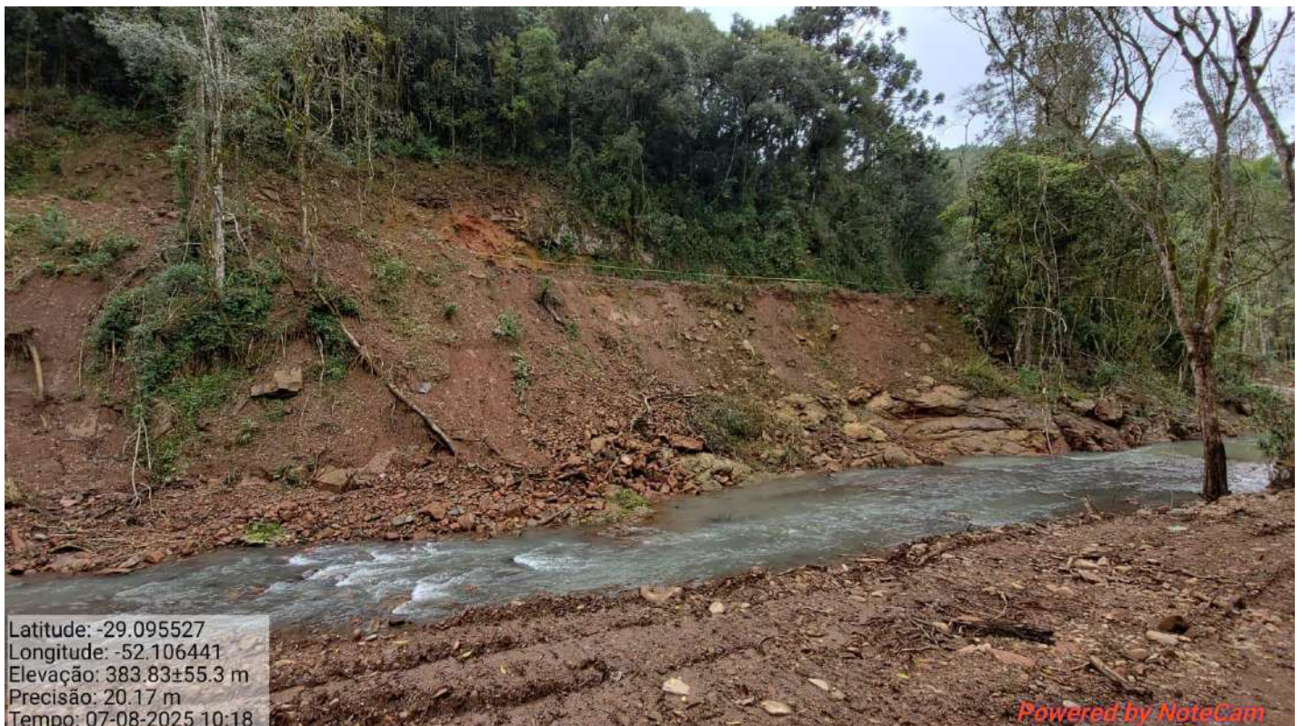
Figura 8: vista do talude inferior e da estrada pela margem oposta do arroio. Percebe-se que os deslizamentos foram circulares, afetando a largura da via. No pé do talude há detritos dos deslizamentos, demonstrando erosão ativa. Também pode-se visualizar árvores caídas no talude. Data das imagens: 07/08/2025. Coordenadas: latitude -29.095527° e longitude -52.106441°. Fonte: Município de Relvado.
