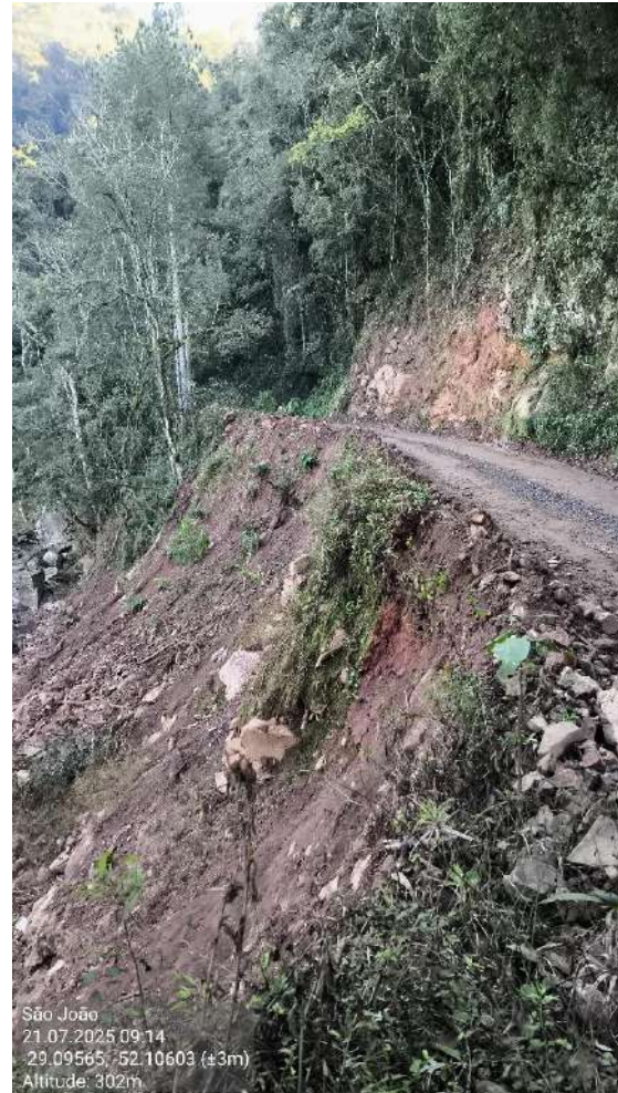
Figura 4: Evidenciada a necessidade de cortina atirantada para sustentar a via. Percebe-se evidências de desmoronamento de parte do talude, principalmente próximas ao nível da estrada, no trecho mais íngreme, evidenciando a instabilidade do talude. Data da imagem 21/07/2025. Coordenadas latitude -29.09556° e longitude -52.10610°; latitude -29.09565° e longitude -52.10603°. Fonte: Progettare Engenharia e Assessoria.
