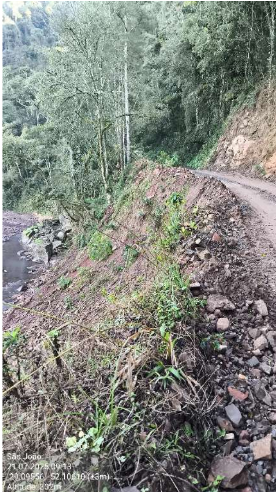
Figura 4: Evidenciada a necessidade de cortina atirantada para sustentar a via. Percebe-se evidências de desmoronamento de parte do talude, principalmente próximas ao nível da estrada, no trecho mais íngreme, evidenciando a instabilidade do talude. Data da imagem 21/07/2025. Coordenadas latitude -29.09556° e longitude -52.10610°; latitude -29.09565° e longitude -52.10603°. Fonte: Progettare Engenharia e Assessoria.
