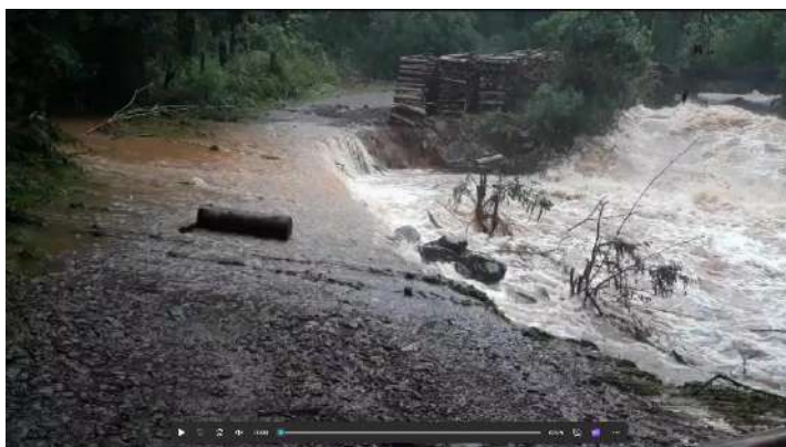
Figura 10: imagens do trecho em maio de 2024, quando a via foi destruída. Percebe-se a erosão tamanha que cortou a estrada em dois pontos. Fonte: acervo da Prefeitura Municipal de Relvado.
