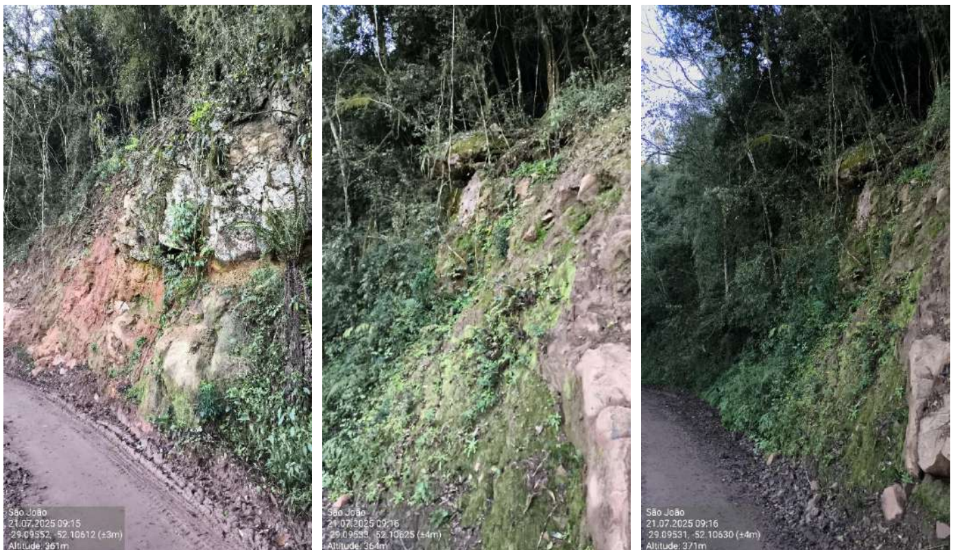
Figura 6: talude superior com rochas fragmentadas e visível ocorrência recente de deslizamento na primeira imagem. Data da imagem 21/07/2025. Coordenadas latitude -29.09552^\circ e longitude -52.10612^\circ ; latitude -29.09533^\circ e longitude -52.10625^\circ ; latitude -29.09531^\circ e longitude -52.10630^\circ . Fonte: Progettare Engenharia e Assessoria.
