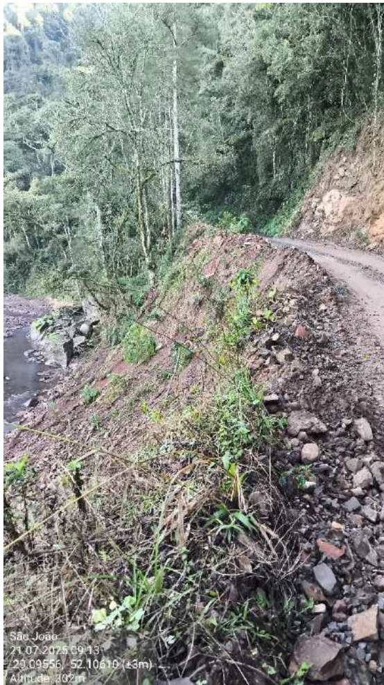
Figura 4: Evidenciada a necessidade de cortina atirantada para sustentar a via. Percebe-se evidências de desmoronamento de parte do talude,
