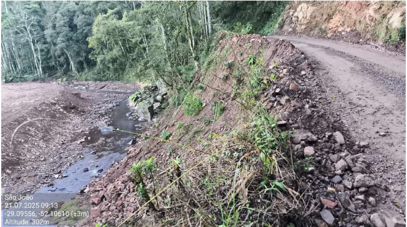
Figura 3: vista de outro ângulo do talude inferior. Proteção da via com lera de terra de forma ineficiente, aumentando o ângulo no topo, de material de aterro. Ainda, a falta de drenagem eficiente aumenta o desgaste do maciço, que perde coesão do solo natural, muito perigoso em situações de instabilidade. Também a imagem demonstra a trajetória do Arroio Jacaré com a tangência da correnteza propícia para erodir o pé do talude, provocando o solapamento do mesmo. Data da imagem: 21/07/2025. Coordenadas latitude -29.09556° e longitude -52.10610°. Fonte: Progettare Engenharia e Assessoria.
