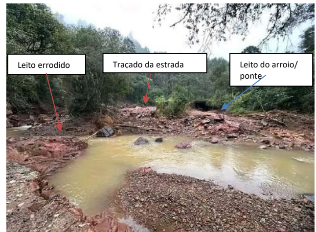
Figura 10: imagens do trecho em maio de 2024, quando a via foi destruída. Percebe-se a erosão tamanha que cortou a estrada em dois pontos. Fonte: acervo da Prefeitura Municipal de Relvado.
