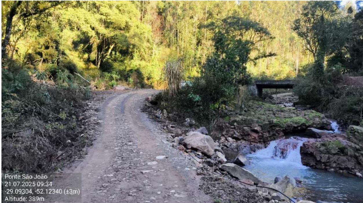
Figura 13: imagem da via demonstrando o nível anterior da via onde foi erodida, salientando que a ponte esta condenada e a estrada do outro lado da ponte se encontra na mesma situação. Data da imagem: 21/07/2025. Fonte: Progettare Engenharia e Assessoria. Coordenadas: latitude - 29.09304° e longitude -52.12340°.
