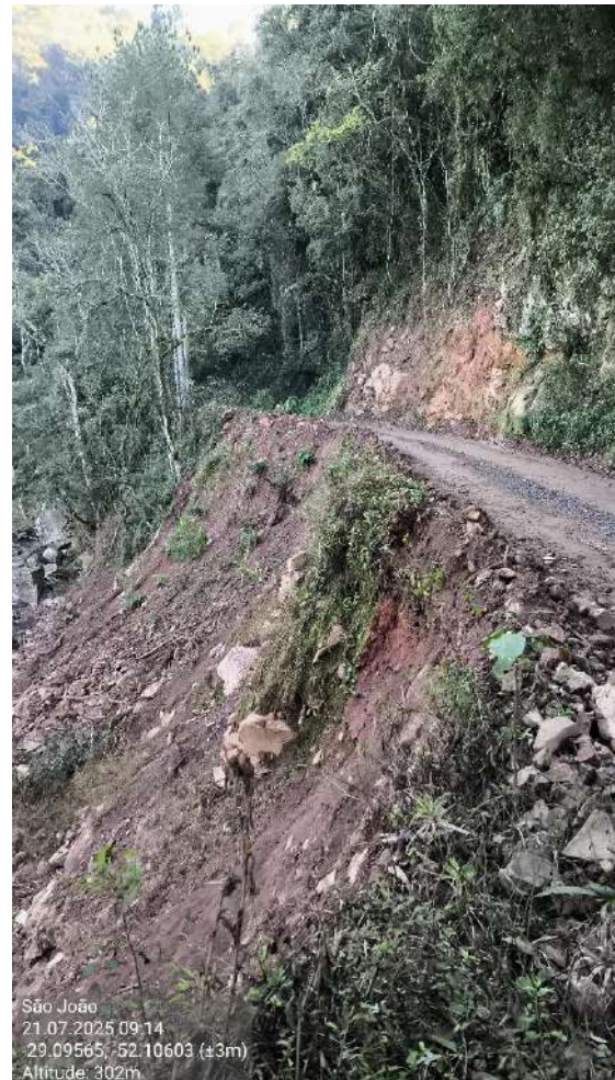
Figura 4: Evidenciada a necessidade de cortina atirantada para sustentar a via. Percebe-se evidências de desmoronamento de parte do talude,
