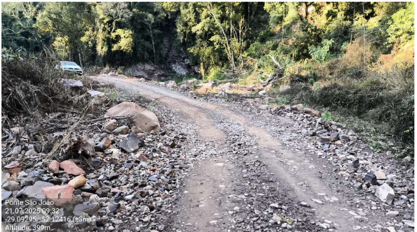
Figura 17: Trecho da estrada onde foi recomposta e sofreu diversas inundações, com material de basalto transportado pelas águas, a esquerda se percebe o caminho que a água abriu na inundação de maio. Data da imagem: 21/07/2025. Fonte: Progettare Engenharia e Assessoria. Coordenadas: latitude -29.09295° e longitude -52.12416°.
