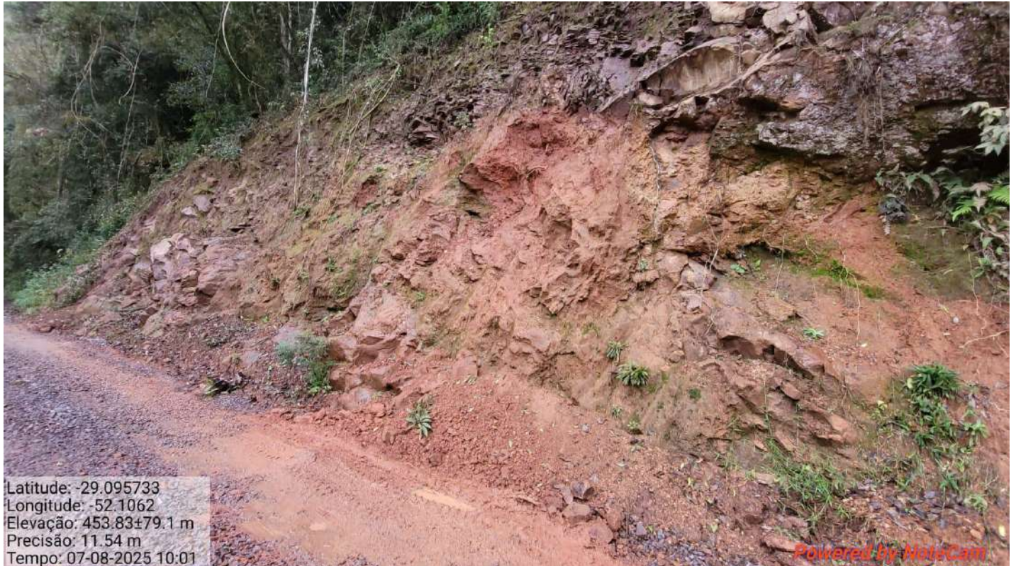
Figura 7: talude superior sofreu um novo deslizamento. Coordenadas: latitude -29,095733° e longitude -52,1062°. Data da imagem 07/08/2025. Fonte: Município de Relvado.
