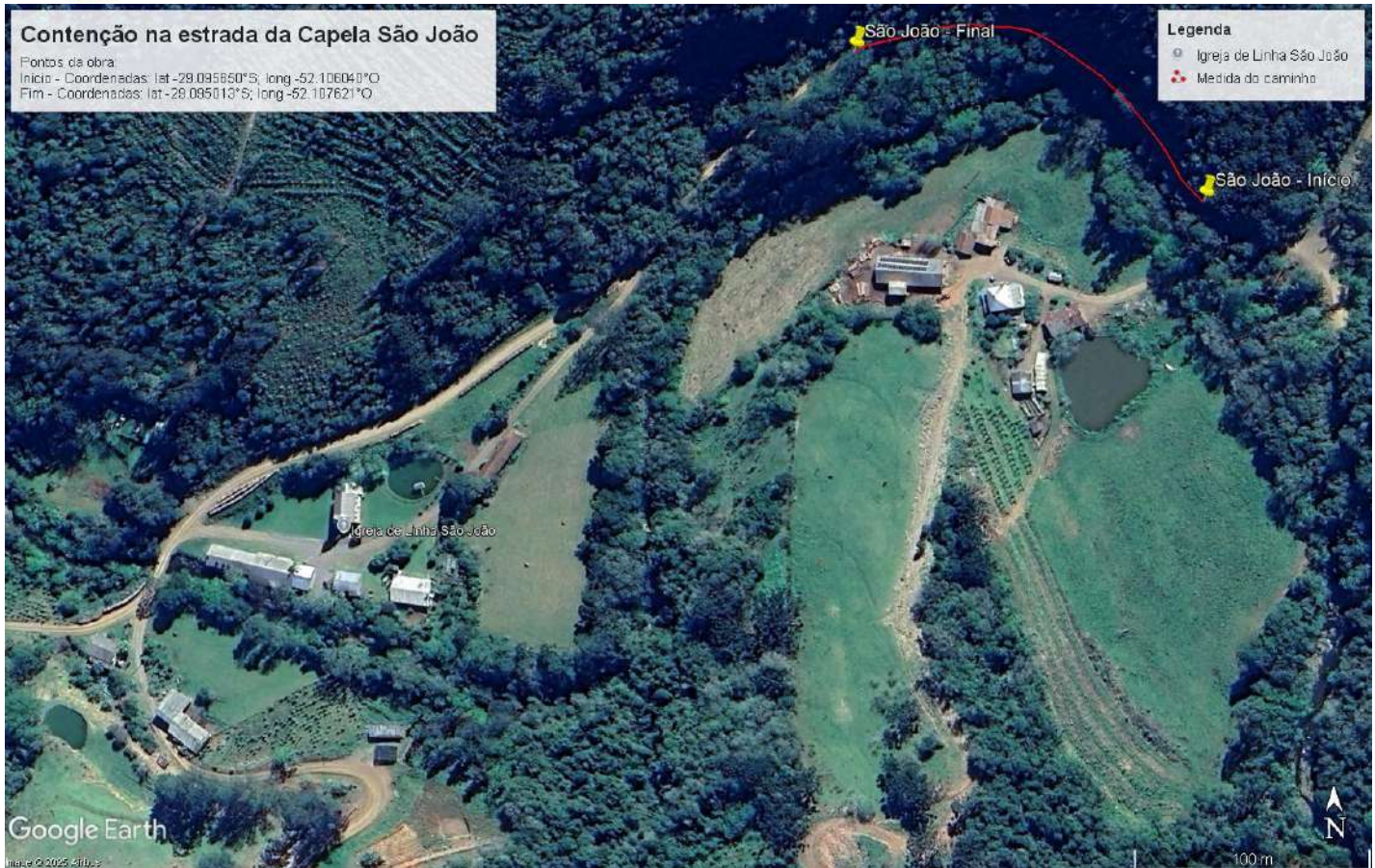
Figura 1: Localização da meta 1, localizada na Estrada São João. Na imagem pode-se observar que a estrada era totalmente envolta em vegetação, sendo difícil inclusive a sua visualização. Após os deslizamentos ocorridos devido as chuvas, o trecho perdeu praticamente toda a vegetação. Coordenadas latitude -29.095650^\circ e longitude -52.106040^\circ . Fonte Google Earth. Data da imagem de satélite: 24/08/2023.
