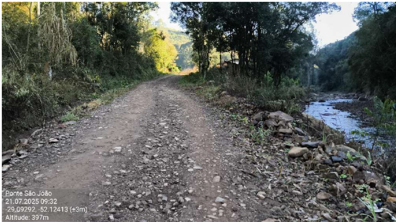
Figura 16: Estrada recomposta no começo do nível inicial de alteamento, evidenciada a necessidade de recompor o talude da estrada com o arroio com material pétreo, para evitar a erosão do aterro. Data da imagem: 21/07/2025. Fonte: Progettare Engenharia e Assessoria. Coordenadas: latitude -29.09292° e longitude -52.12413°.
