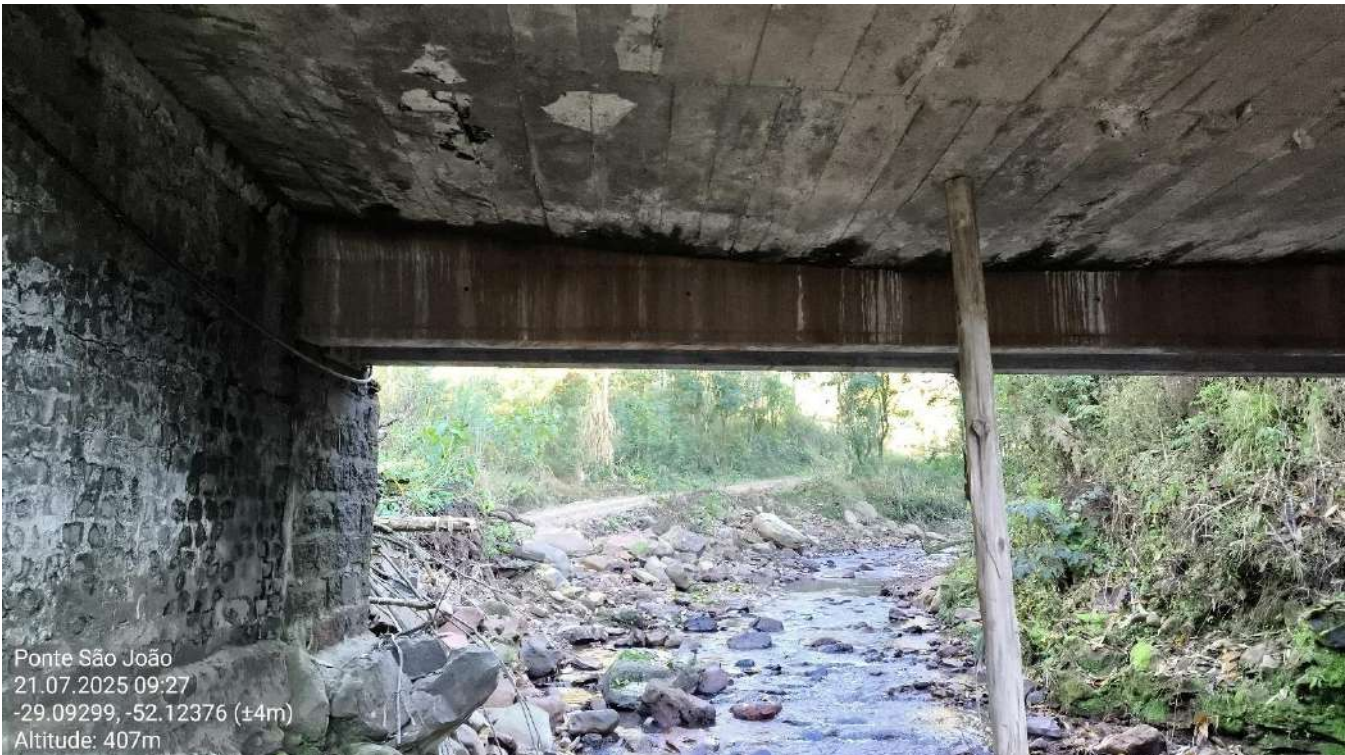
Figura 6 Cabeceira com trincas, flecha e eflorescências no tabuleiro. Data da imagem 21/07/2025. Coordenadas latitude -29.09299° e longitude -52.12376°. Fonte: Progettare Engenharia e Assessoria.
