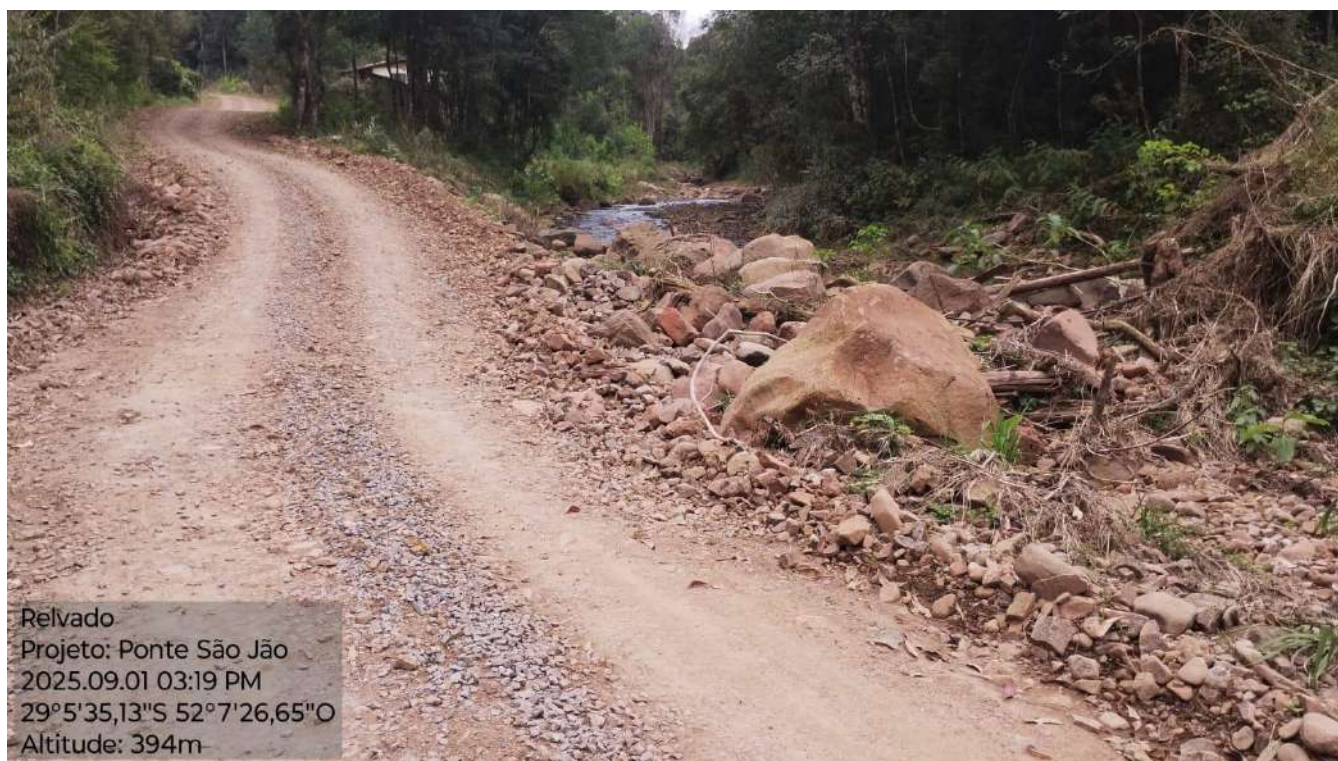
Figura 7: registro à montante da ponte, evidenciando a grande quantidade de entulhos, blocos rochosos e material vegetal arrastados pela cheia de junho de 2025 , os quais se acumularam junto ao leito e margens do arroio. O volume de detritos e a erosão registrada no entorno comprovam a magnitude do evento climático e seus efeitos diretos sobre a estrutura, que sofreu esforços excepcionais resultando em fissuras, recalques e comprometimento da estabilidade , culminando na necessidade de interdição e caracterização de colapso iminente . Coordenadas: latitude 29°5'35,13"S e longitude 52°7'26,65"O. Fonte: Progettare Engenharia e Assessoria.
