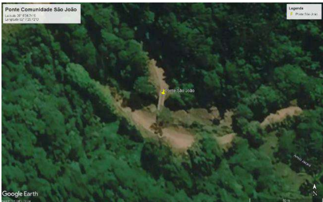
Figura 1: localização da ponte avaliada. Coordenadas: latitude 29° 5'34.74"S e longitude 52° 7'25.72"O. Fonte Google Earth.
