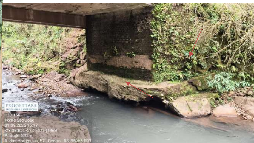
Figuras 9 e 10: detalhes da cabeceira da ponte, onde se constata o solapamento das fundações provocado pela forte erosão das águas durante a cheia de junho de 2025 . Observa-se a exposição da sapata e a perda de apoio em sua base , situação que compromete a capacidade de sustentação da estrutura. As trincas identificadas na lateral da sapata reforçam o quadro de instabilidade, caracterizando risco iminente de colapso . Data das imagens: 21/07/2025 e 01/09/2025. Coordenadas: latitude -29.09305° e longitude -52.12382°; latitude -29.09303° e longitude -52.12377°. Fonte Progettare Engenharia e Assessoria.
