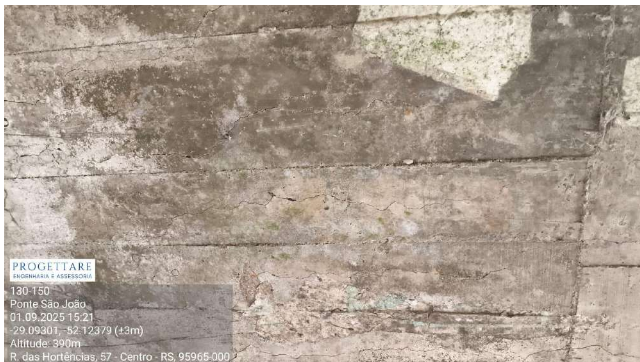
Figura 4: vista superior do tabuleiro na pista de rolamento, onde se evidencia recalque diferencial da laje , com flecha excessiva que ultrapassa os limites admissíveis do estado limite de serviço. O abatimento do pavimento, aliado à presença de fissuras longitudinais, indica perda de capacidade resistente e comprometimento da estabilidade global da superestrutura. Coordenadas: latitude 29°5'34,93"S e longitude 52°7'25,85"O. Data da imagem: 01/09/2025. Fonte: Progettare Engenharia e Assessoria.
