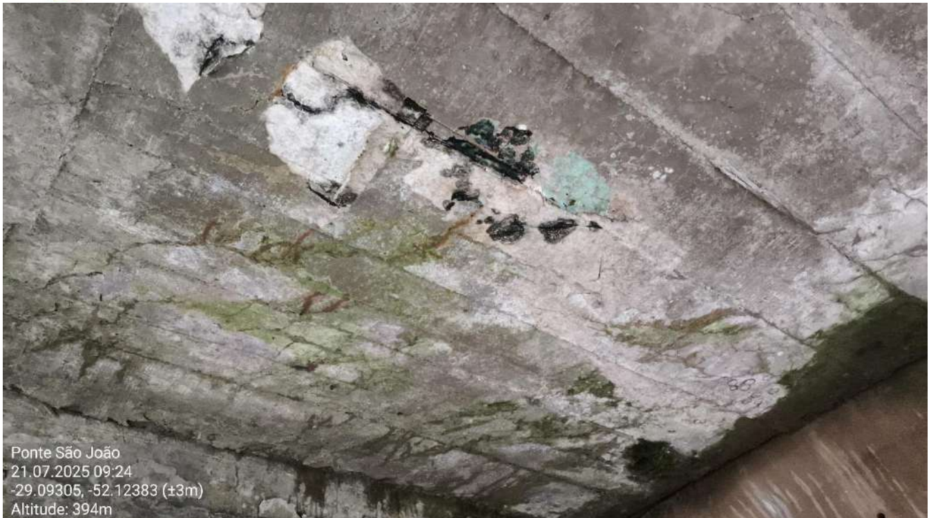
Figura 5 Eflorescências e rachaduras no tabuleiro. Data da imagem 21/07/2025. Coordenadas latitude -29.09305° e longitude -52.12383°. Fonte: Progettare Engenharia e Assessoria.
