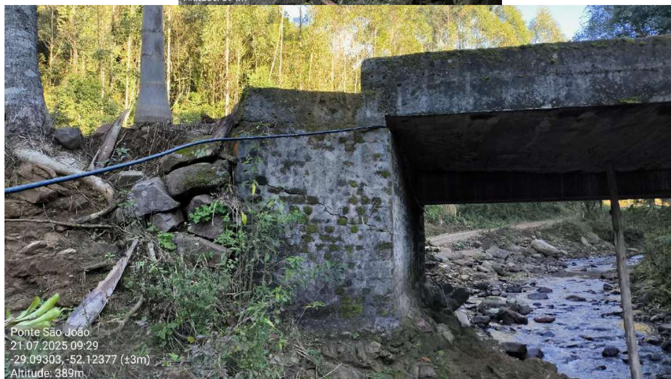
Figura 8 Cabeceira com trincas e deslocamento da alvenaria no topo. Data das imagens: 21/07/2025. Coordenadas: latitude -29.09305° e longitude -52.12382; latitude -29.09303 e longitude -52.12377°. Fonte Progettare Engenharia e Assessoria.
