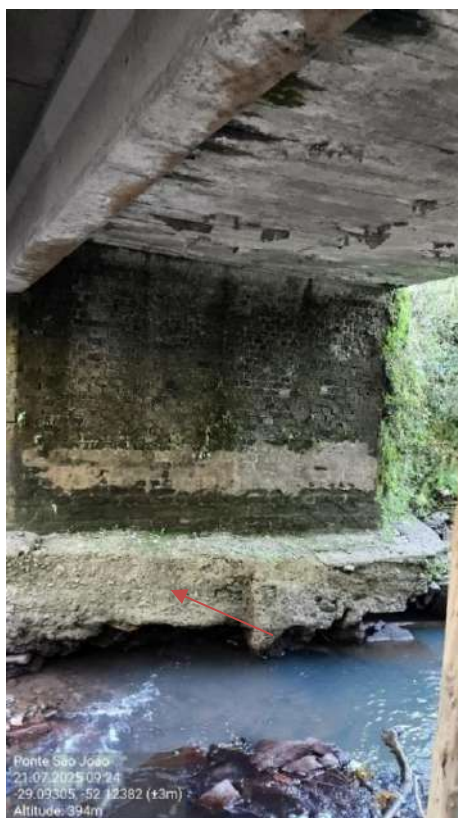
Figuras 9 e 10: detalhes da cabeceira da ponte, onde se constata o solapamento das fundações provocado pela forte erosão das águas durante a cheia de junho de 2025 . Observa-se a exposição da sapata e a perda de apoio em sua base , situação que compromete a capacidade de sustentação da estrutura. As trincas identificadas na lateral da sapata reforçam o quadro de instabilidade, caracterizando risco iminente de colapso . Data das imagens: 21/07/2025 e 01/09/2025. Coordenadas: latitude -29.09305° e longitude -52.12382°; latitude -29.09303° e longitude -52.12377°. Fonte Progettare Engenharia e Assessoria.
