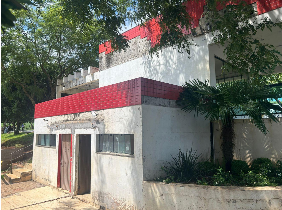
Imagem 07 – Área externa da edificação
