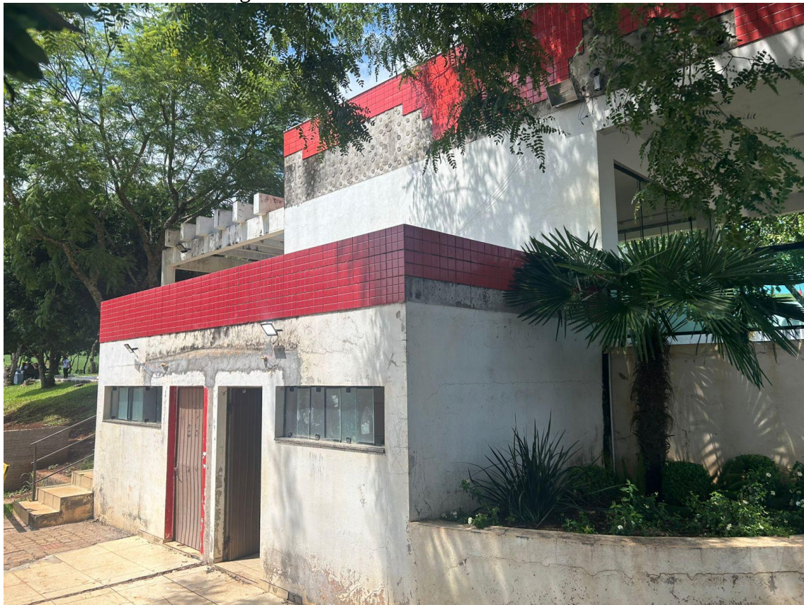
Imagem 02 – Parte externa dos banheiros existentes
