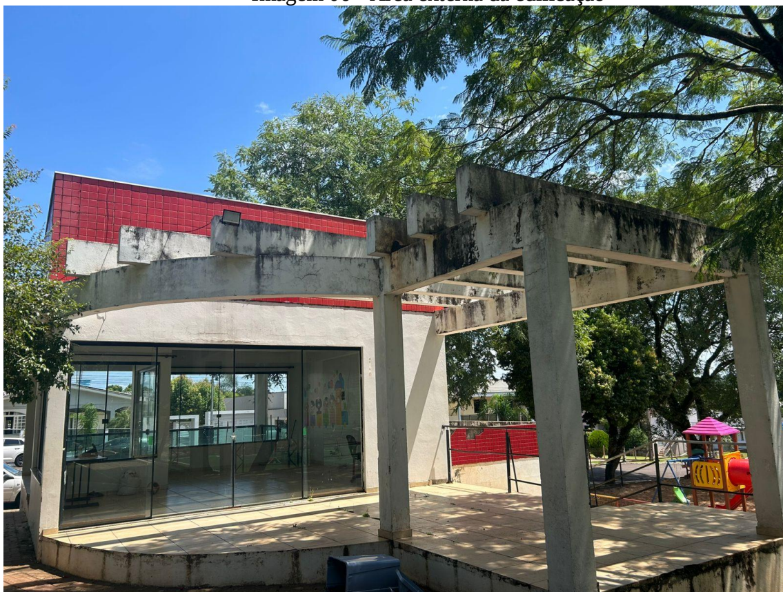
Imagem 06 - Área externa da edificação
