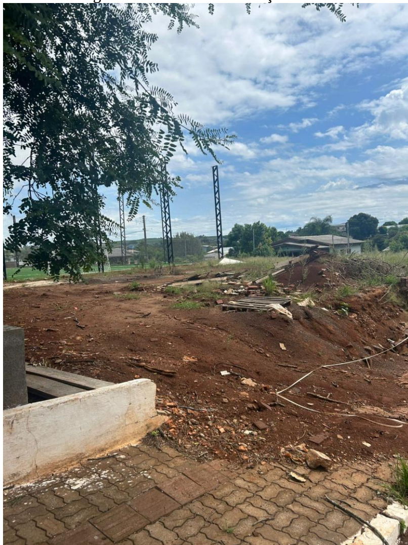
Imagem 01 – Local de construção de muro
