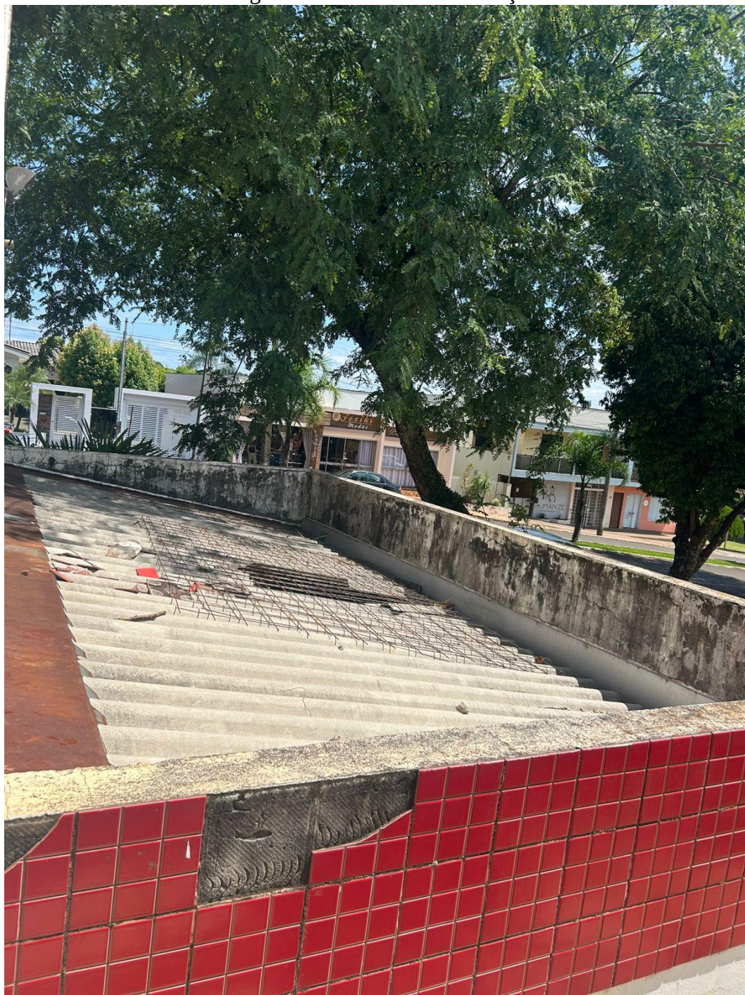
Imagem 08 – Telhado da edificação
