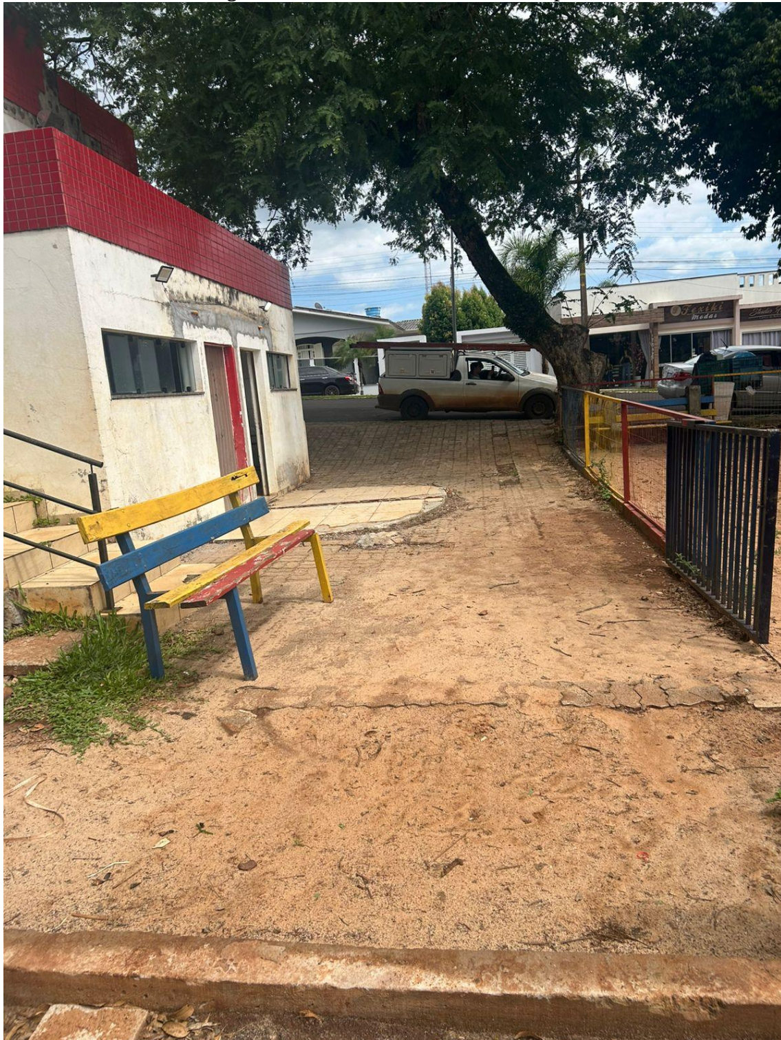
Imagem 05 – Local onde será executado piso externo
