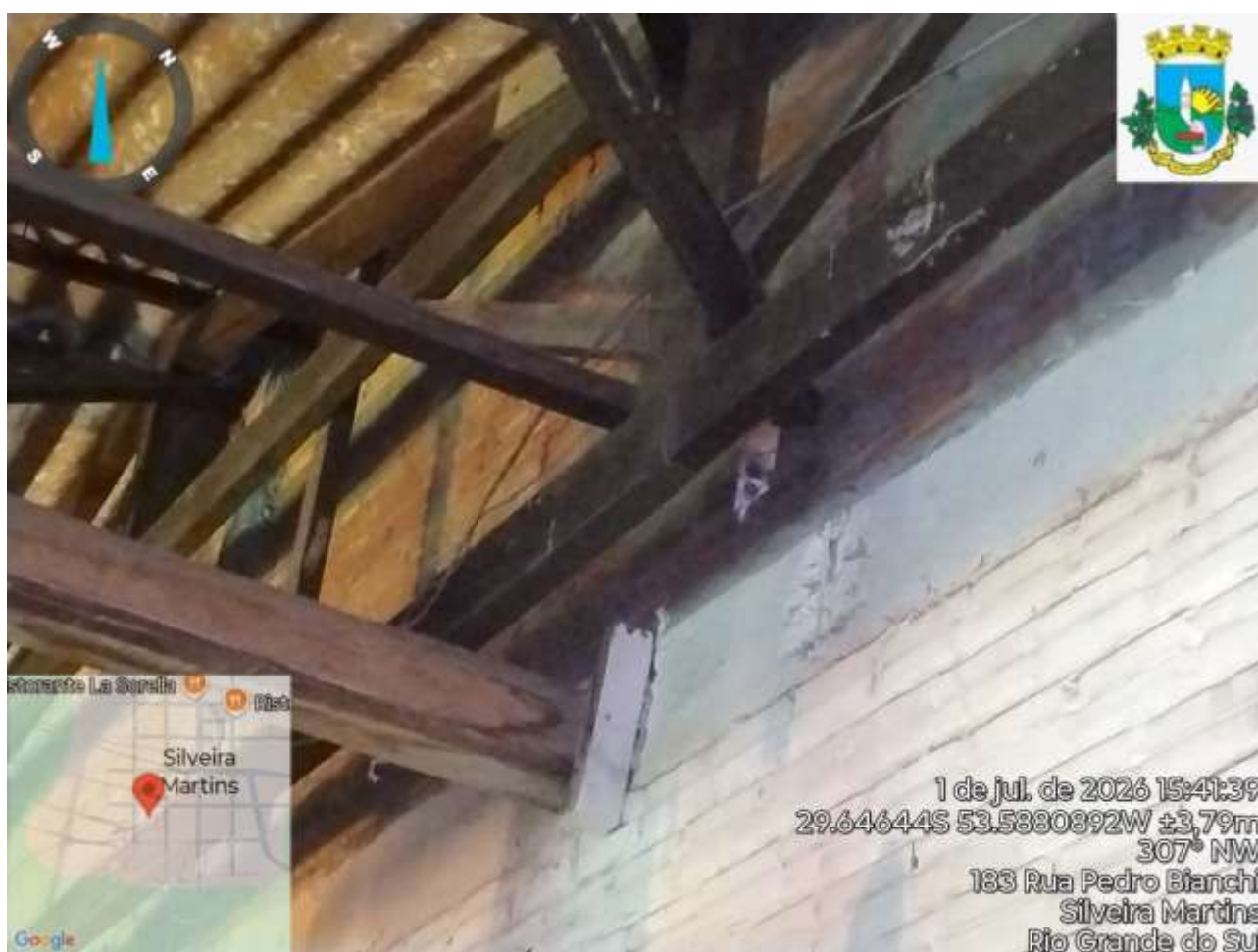
Figuras 6 e 7 – Vista Interna da estrutura de tesouras e tramas em madeira do prédio da Secretaria Municipal de Infraestrutura e Trânsito
