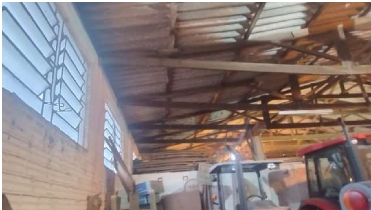
Figuras 4 e 5 – Vista Interna do prédio da Secretaria Municipal de Infraestrutura e Trânsito
