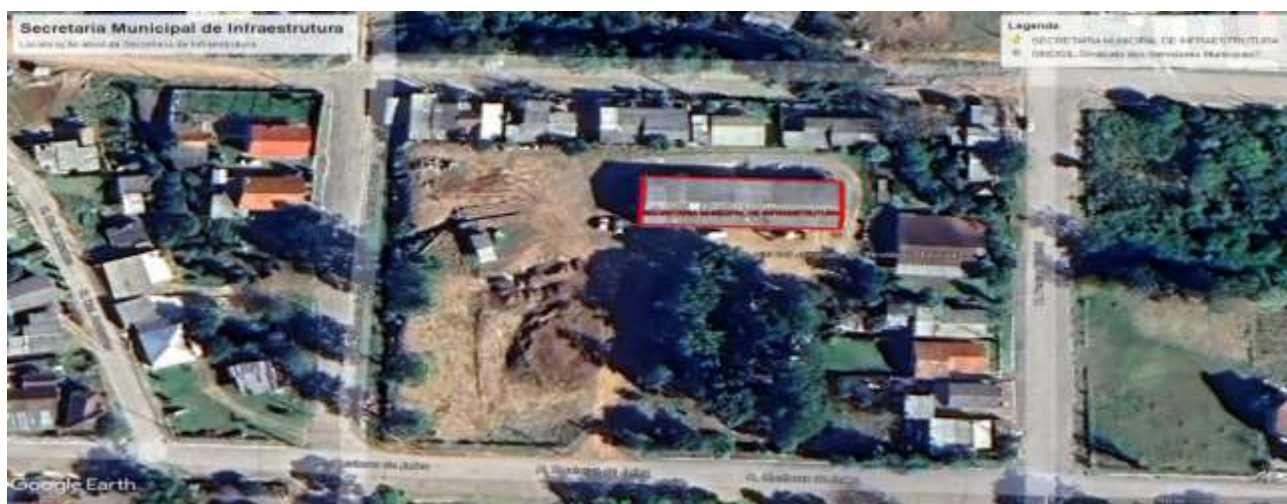
Figura 1 – Localização Atual do prédio da Secretaria Municipal de Infraestrutura e Trânsito
