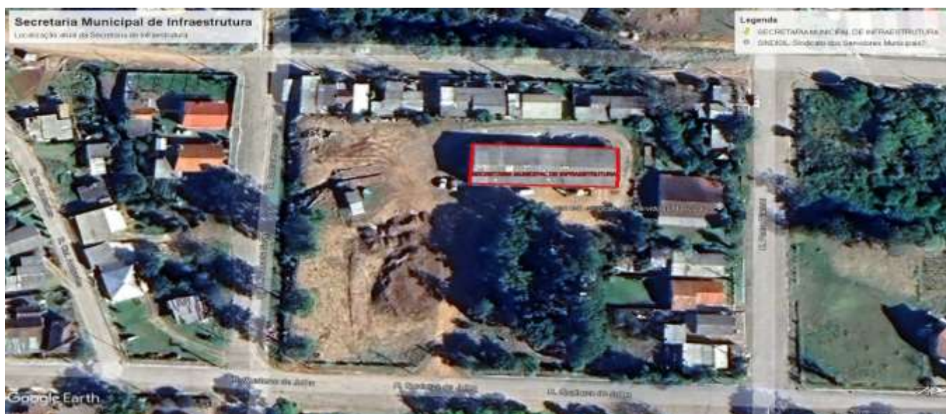
Figura 1 - Localização Atual do prédio da Secretaria Municipal de Infraestrutura e Trânsito
