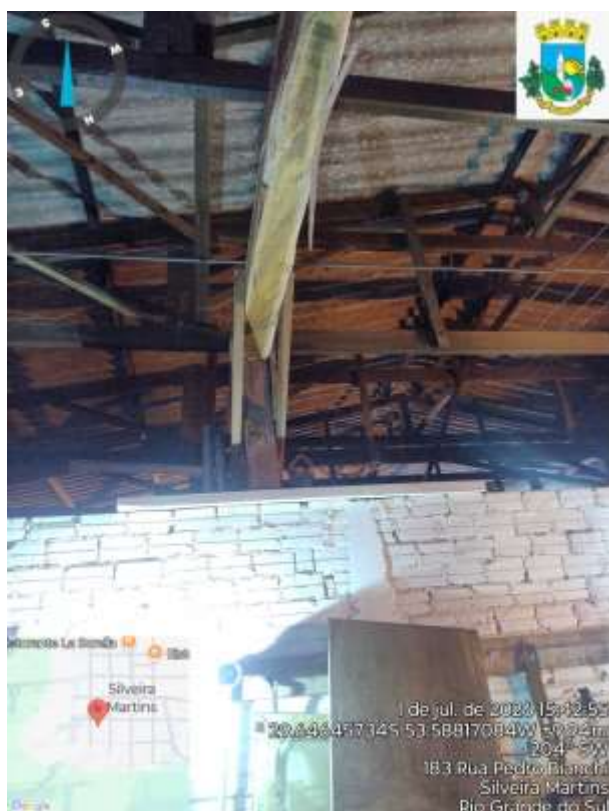
Figuras 8 a 11 – Vista Interna da estrutura de tesouras e tramas em madeira do prédio da Secretaria Municipal de Infraestrutura e Trânsito e infraestrutura de paredes e vigamento
