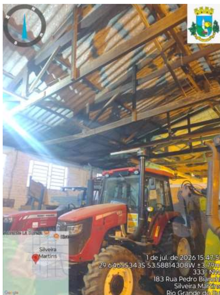
Figuras 12 e 13 – Pontos com manifestações patológicas de flambagem e flechas nas tesouras.
