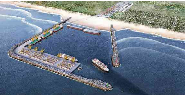
Estrutura em Arroio do Sal terá investimento de R$ 1,3 bilhão
