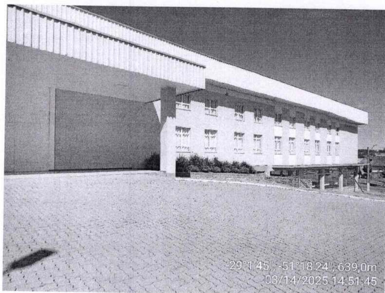
VISTA FACHADA OESTE – ACESSO II
