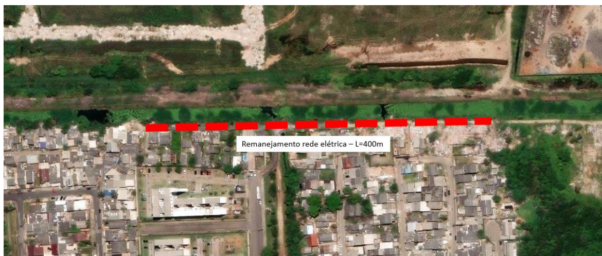
Figura 26: Remanejamento de postes de energia Elétrica.
