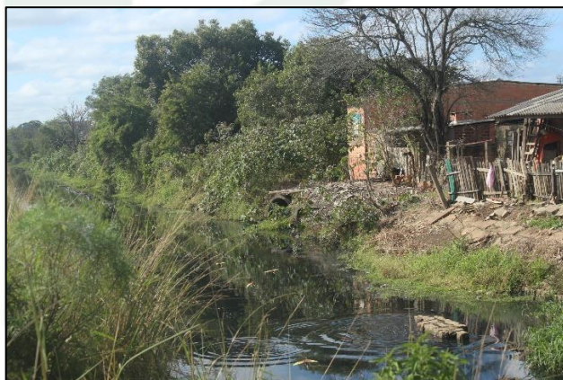
Figura 8 – Residências com registro de deslizamento na beira do canal.
