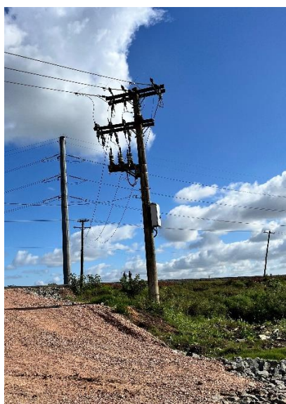
FIGURA 5.20 REDE DISTRIBUIÇÃO EXISTENTE – SUBSTITUIÇÃO POSTES REDE DE DISTRIBUIÇÃO
