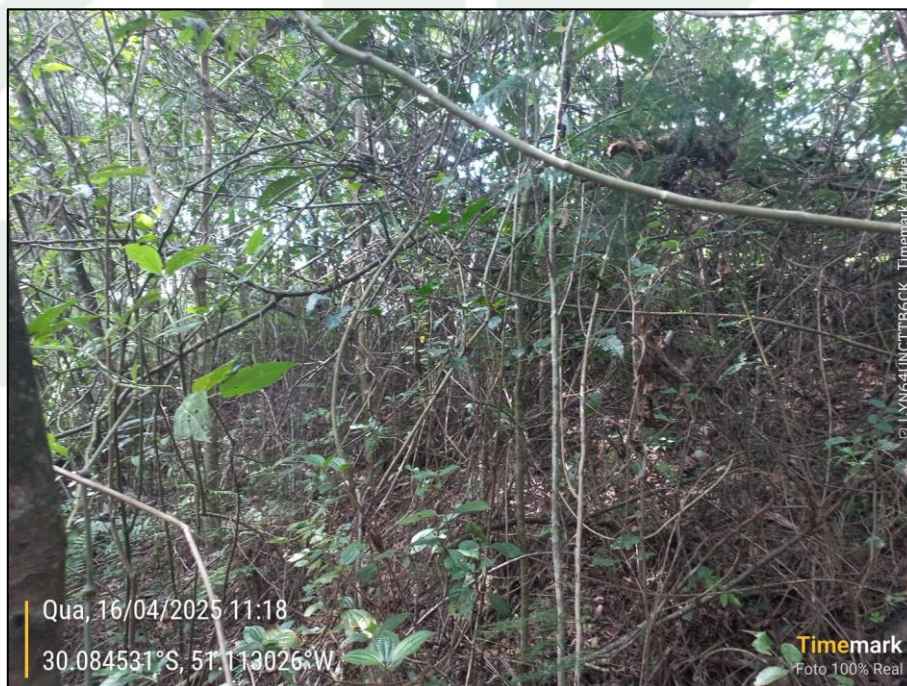
Foto 9- Vegetação junto ao talude a jusante da barragem
