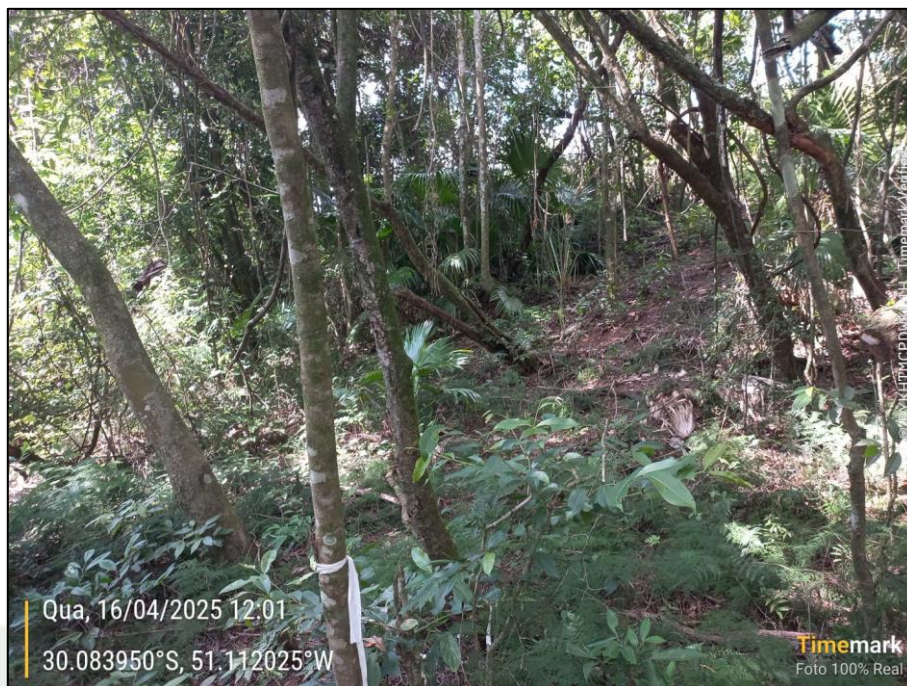
Foto 10 – Vegetação de porte arbóreo estabelecida sobre o talude a jusante
