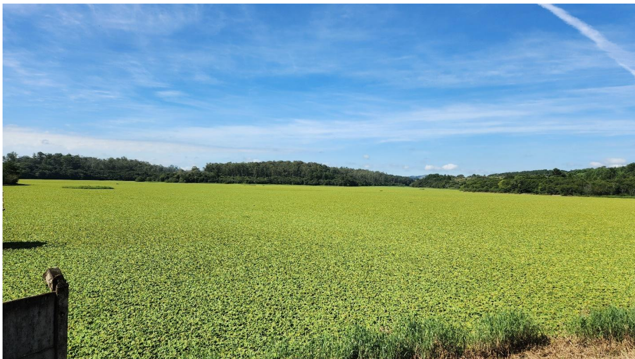
Figura 7. Vista do reservatório da Barragem Lomba do Sabão.
