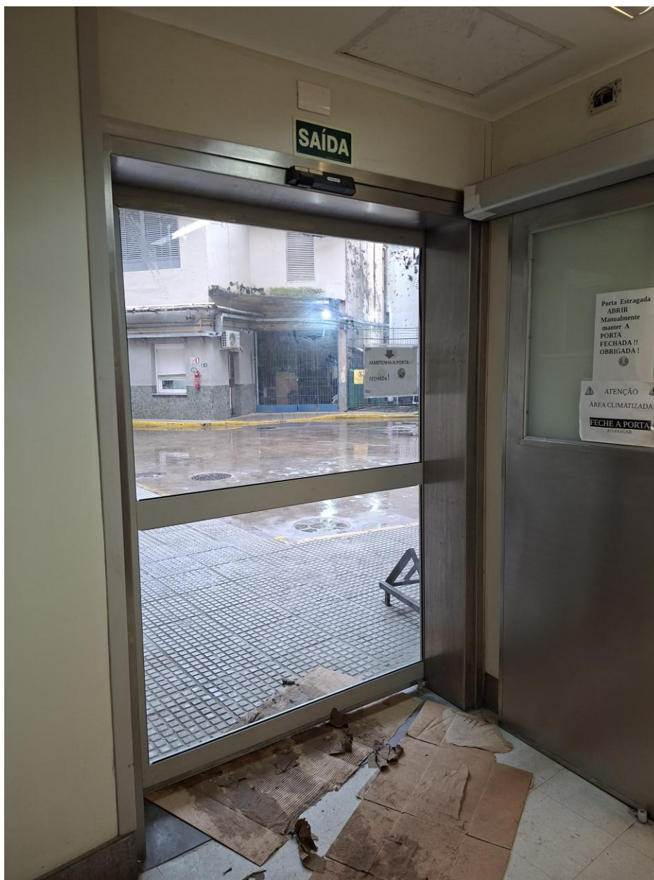
Porta 14: Acesso Pátio Interno Lateral junto ao Diagnóstico por Imagem
