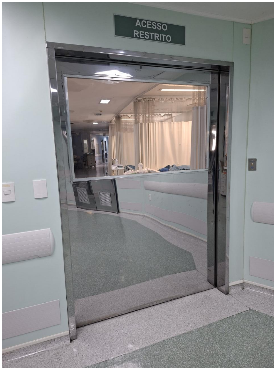
Porta 20: Sala 408 - Sala de Recuperação Interna
