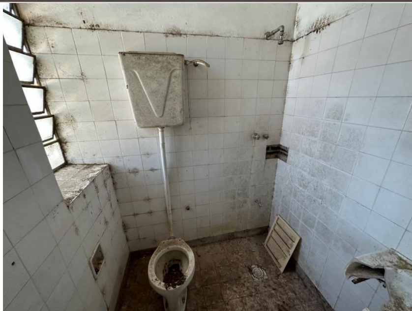
Foto 26 – Interno – Alvenarias Sanitários Foto: Leilah Schäedler
