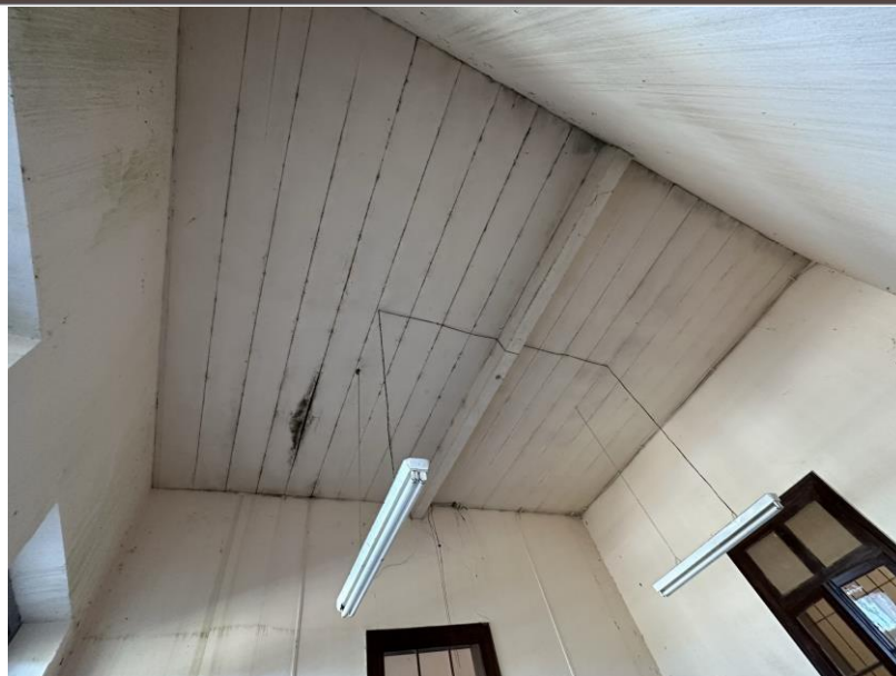
Foto 46 – Interno – Instalações elétricas Foto: Leilah Schäedler
