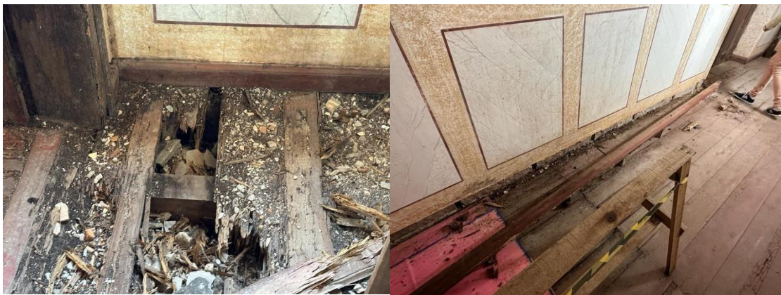
Fotos 4 e 5 – Interno – assoalho e barroteamento Foto: Leilah Schäedler
