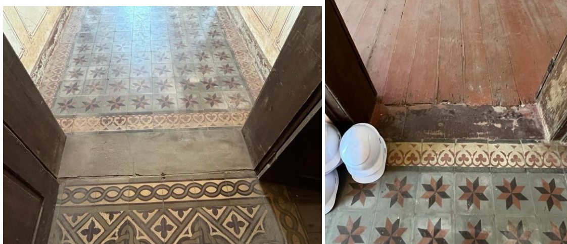
Fotos 9 e 10 – Interno – Soleiras internas em argamassa Foto: Leilah Schäedler
