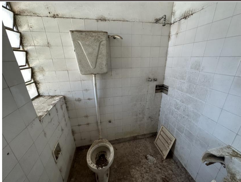
Foto 47 – Interno – Instalações hidrossanitárias Foto: Leilah Schädler
