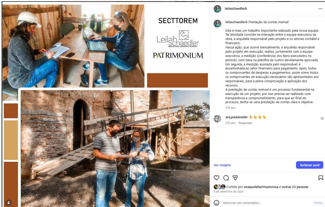
ACOMPANHAMENTO DE OBRAS NA CASA VIDAL – TAQUARA / RS
