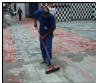
Limpeza e liberação ao tráfego.
