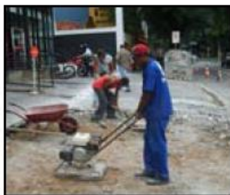
Nivelamento e compactação do subleito (terreno).
