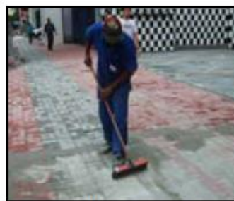
Limpeza e liberação ao tráfego.
