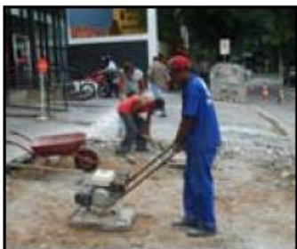
Nivelamento e compactação do subleito (terreno).
