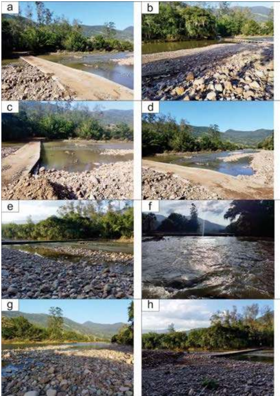
Figura 1 – Imagens da área de interesse no dia do levantamento em campo mostram a atual passagem molhada sobre o rio Maquiné, os sedimentos acumulados e o rio.
