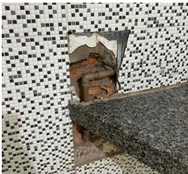
(Figura 1 – Revestimento do banheiro )
