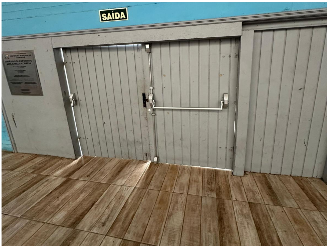
( Figura 5 – Arquibancada do Ginásio)
