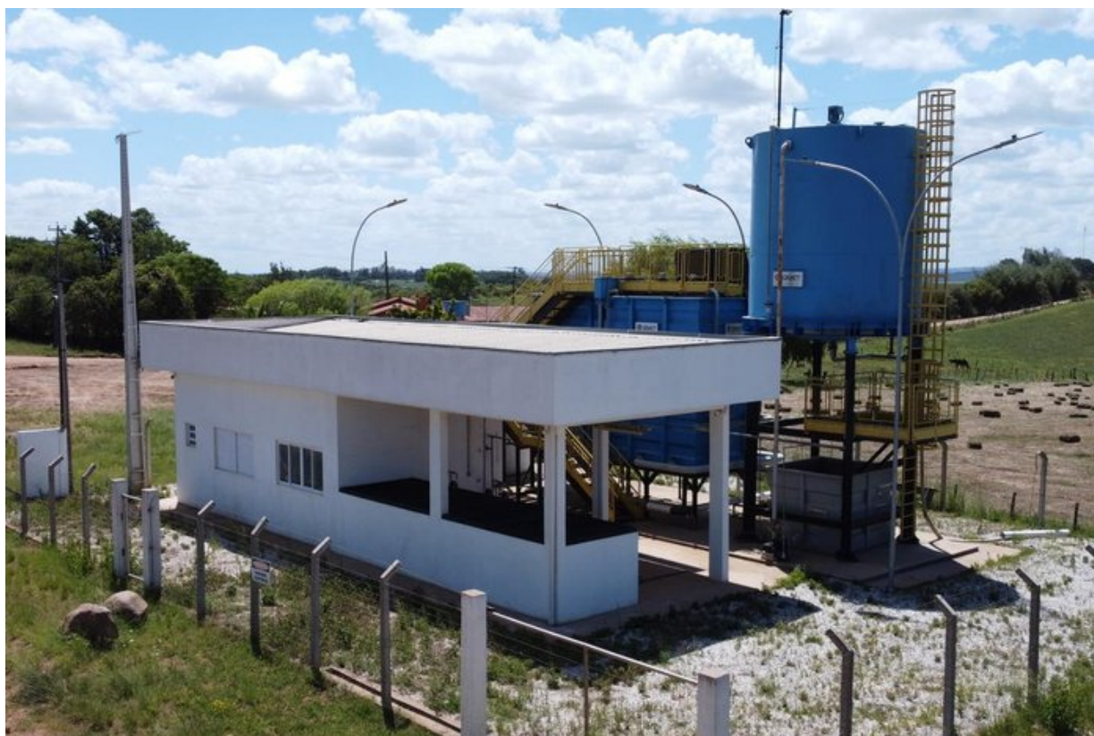
Figura 4 – Estação de Tratamento de Água de HULHA NEGRA-RS, 2025.
