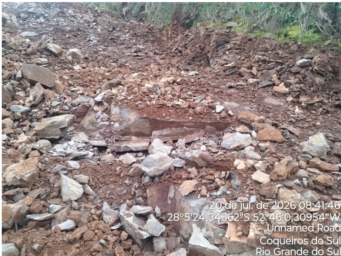
Figura 1: Rocha característica no local da obra
