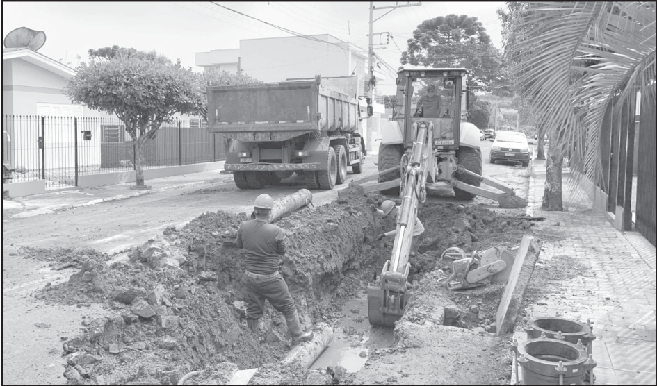
Na mesma manhã, a Corsan realizava os reparos necessários
