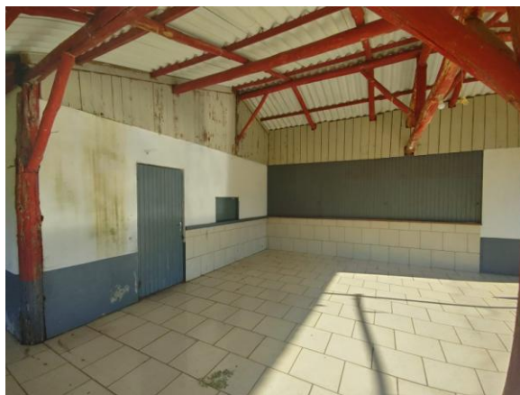
Estrutura existente do telhado em madeira
