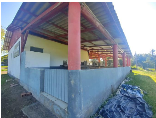
Fachada Oeste e Sul
