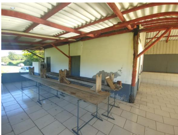
Estrutura existente do telhado em madeira
