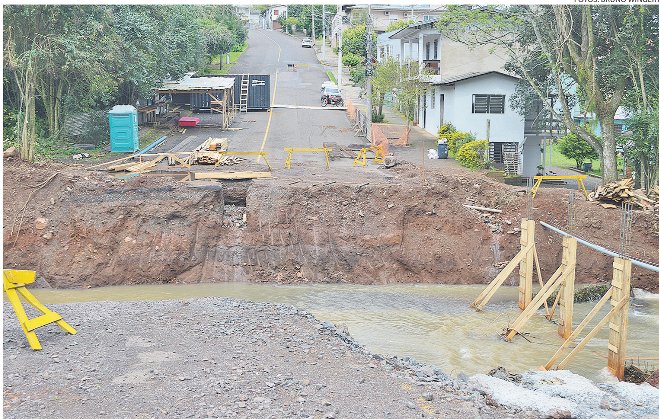
Ponte do bairro Vale Verde está sendo reconstruída
