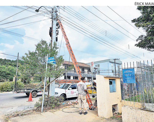
As operadoras deverão reinstalar os cabos necessários após a limpeza
