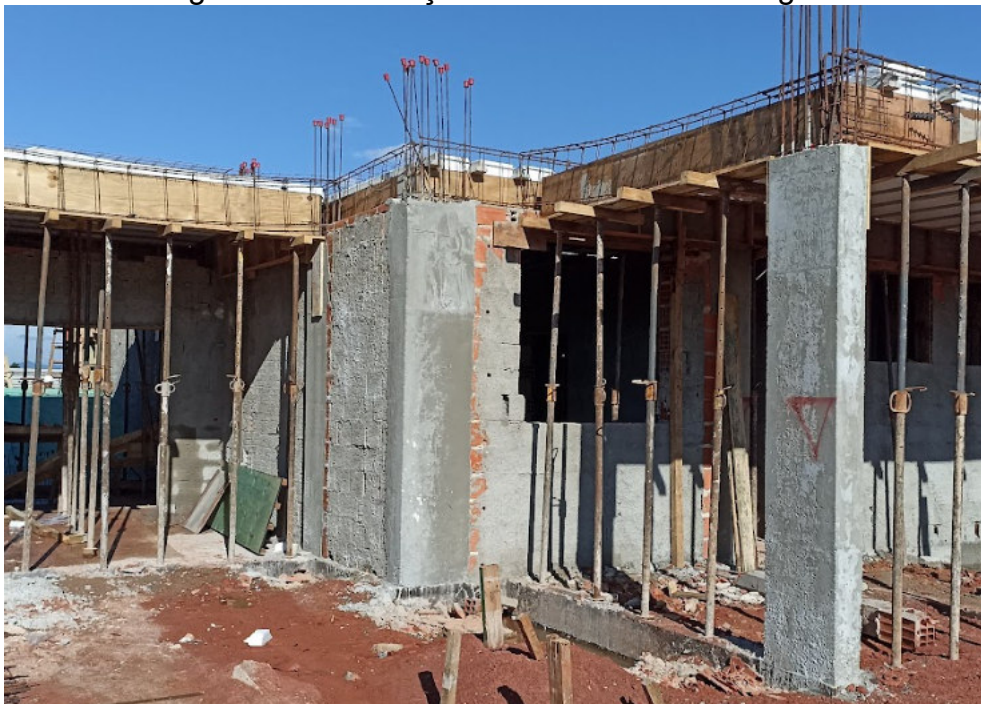
Figura 05 – Execução alvenaria Pilares e vigas
