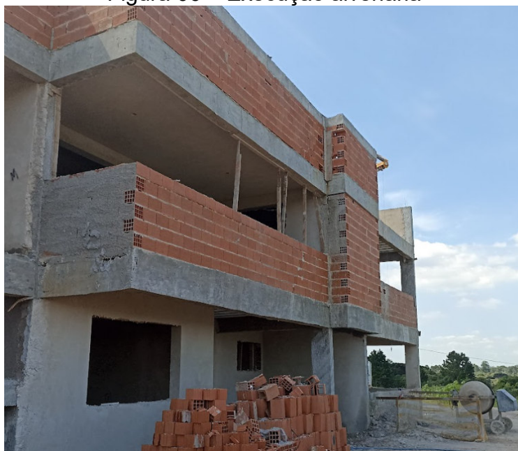
Figura 06 – Execução alvenaria
