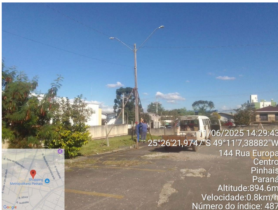
Foto 01 – Tripé posicionado para início da perfuração do furo SP-01. Foto Alexandre.
