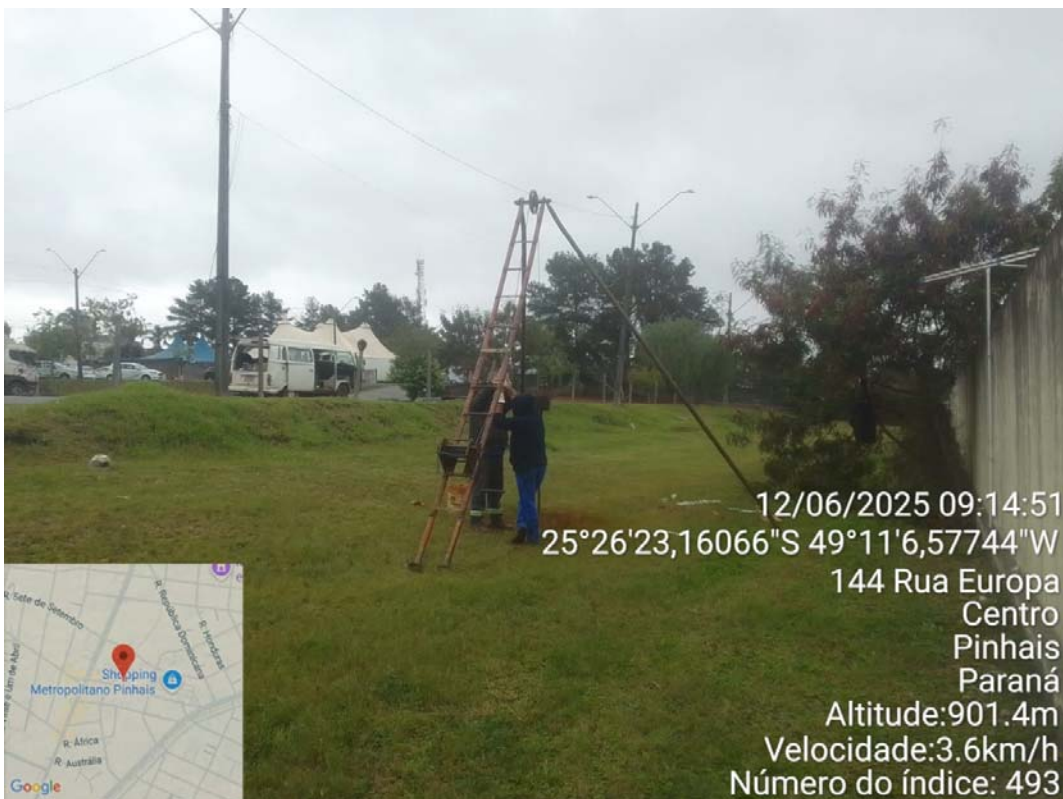
Foto 03 – Perfuração do furo SP-02. Foto Alexandre.
