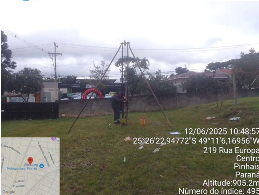
Foto 06 – Outro aspecto da perfuração do furo SP-03. Foto Alexandre.
