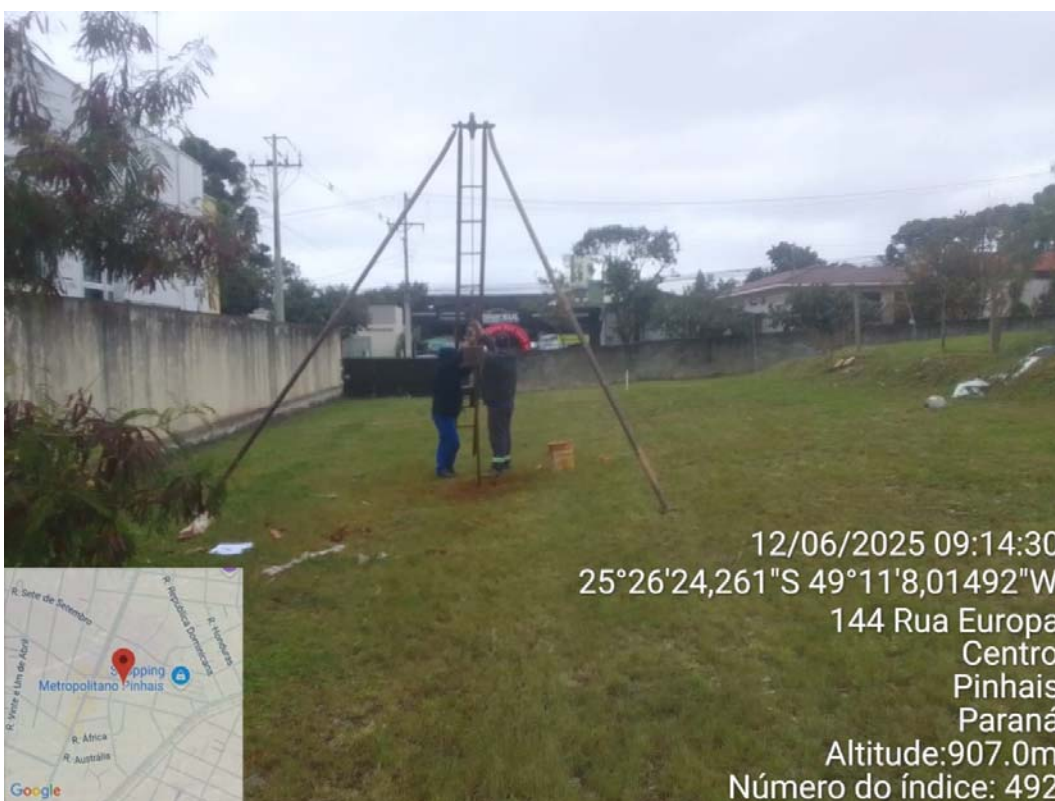
Foto 04 – Outro aspecto da perfuração do furo SP-02. Foto Alexandre.
