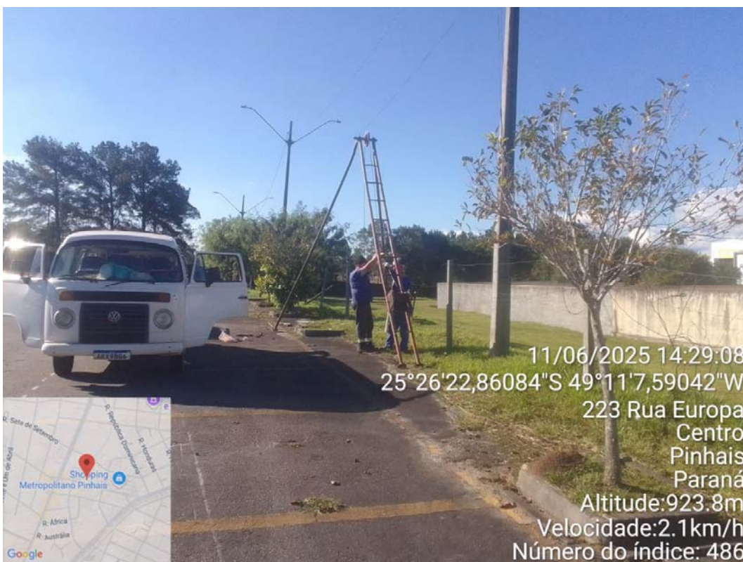
Foto 02 – Perfuração do furo SP-01. Foto Alexandre.
