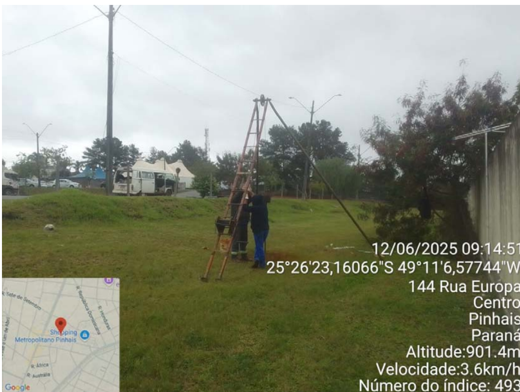
Foto 03 – Perfuração do furo SP-02. Foto Alexandre.
