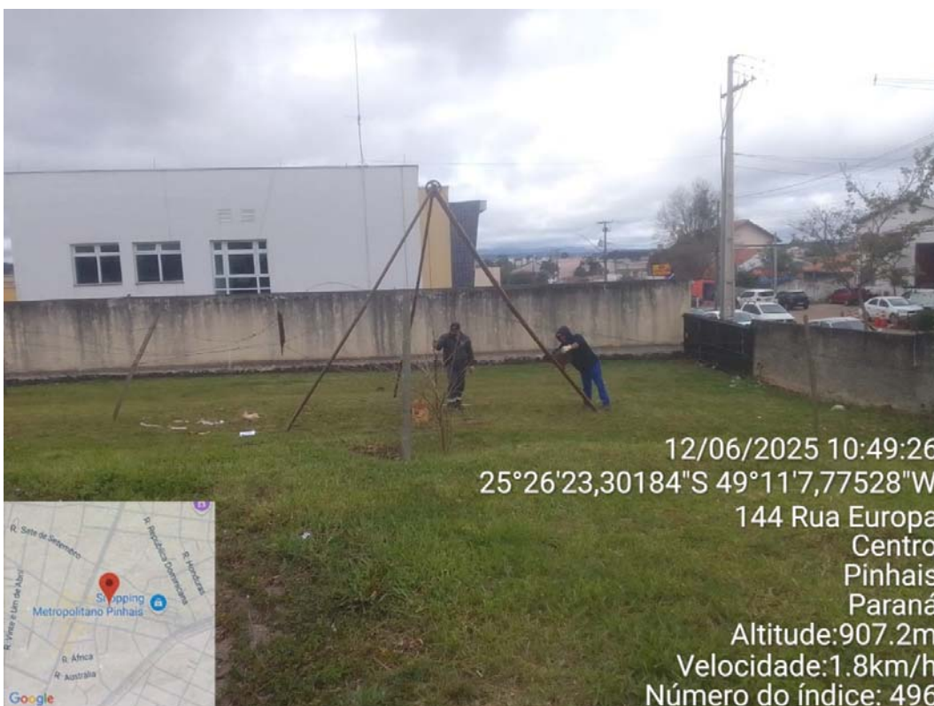
Foto 05 – Perfuração do furo SP-03. Foto Alexandre.
