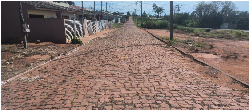
Figura 3 – Vista longitudinal do Trecho 1 da Rua Maria Elisa Geffer.
