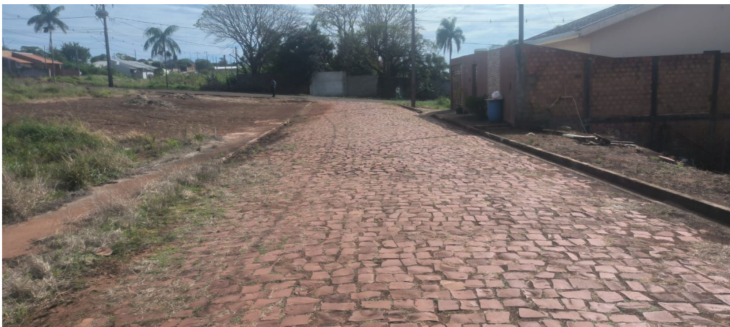
Figura 13 – Vista geral da Rua Amália Cordeiro de Lara e das condições lindeiras.
