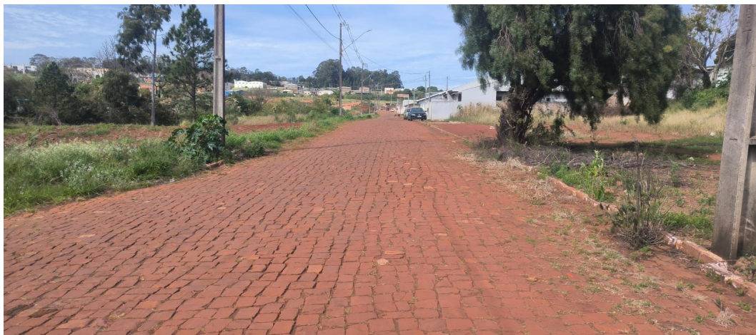
Figura 6 – Vista geral do Trecho 2 da Rua Maria Elisa Geffer.
