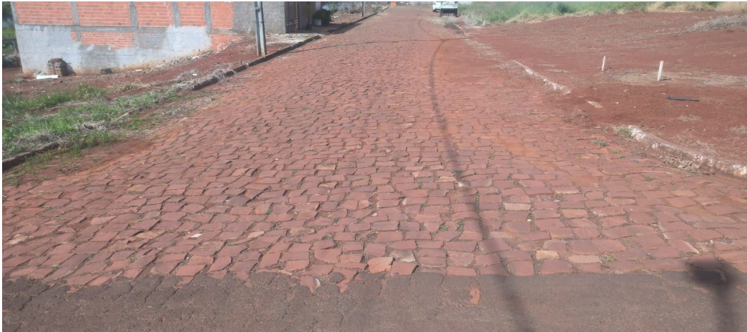
Figura 12 – Vista da superfície de pedras irregulares e de remendo transversal existente.
