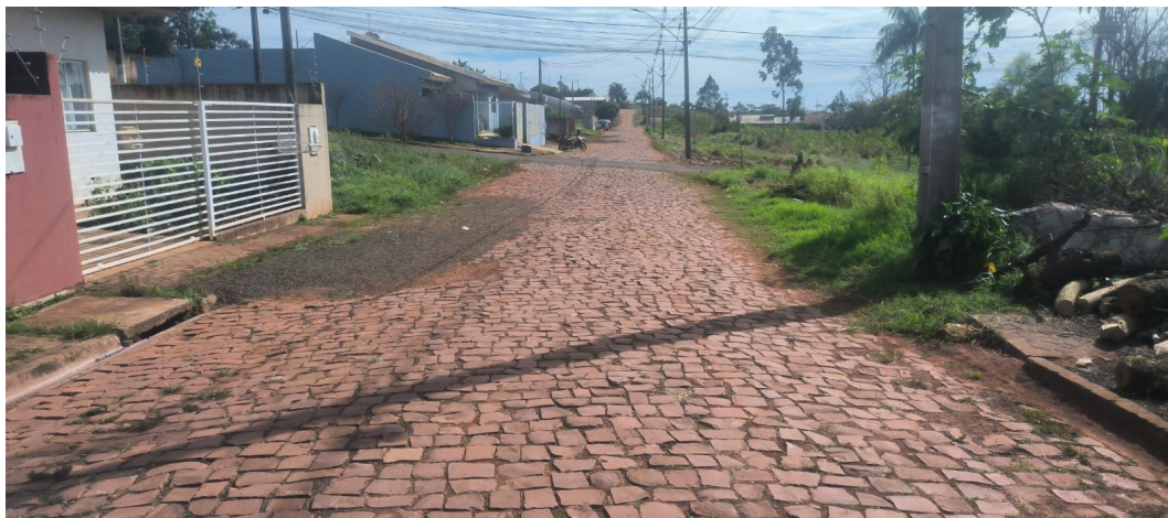
Figura 1 – Vista geral do pavimento em pedras irregulares e das condições de ocupação lindeira.
