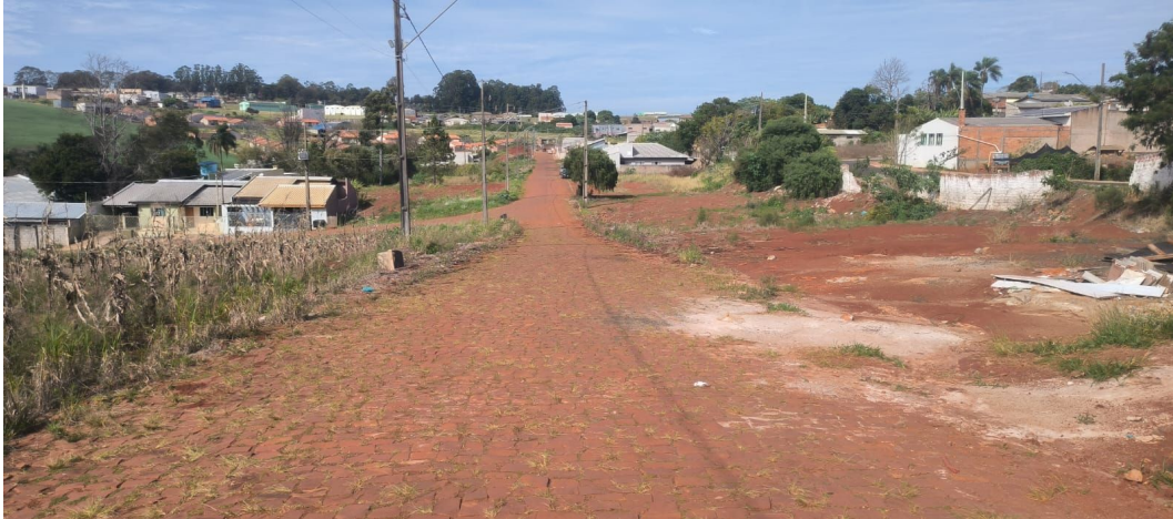
Figura 9 – Vista longitudinal em declive, com acessos laterais e pavimento de pedras irregulares.
