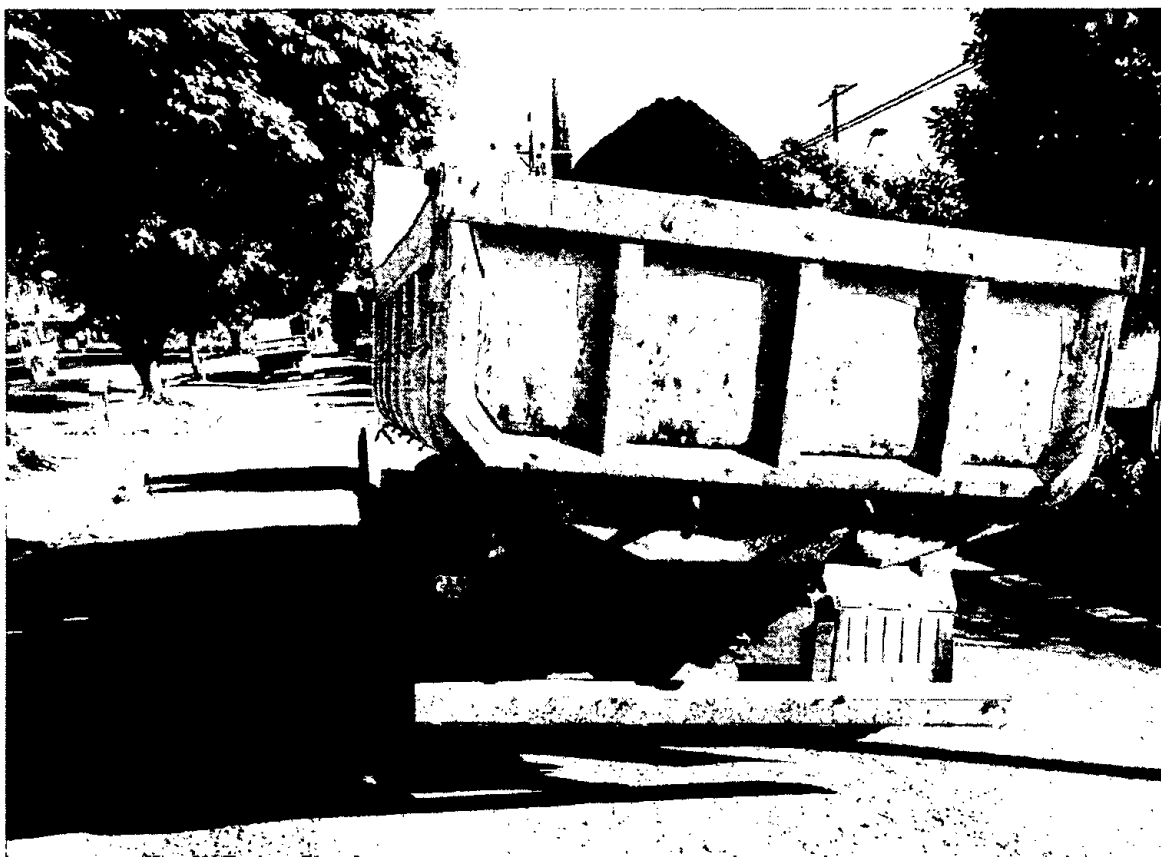
Foto 02: Teste de carga na Av. Brasil, trecho II
