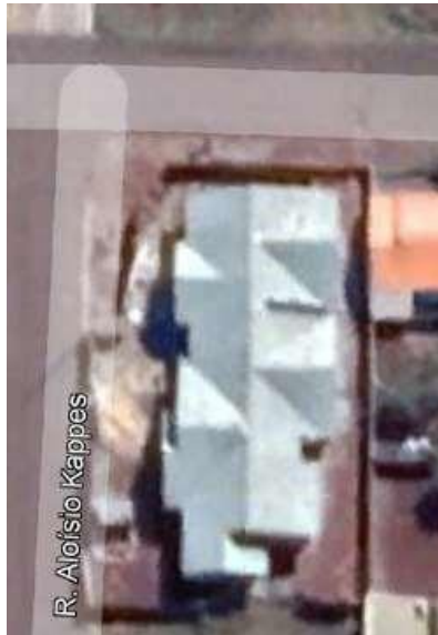
Figura 5 - Imagem da cobertura a ser instalado o sistema fotovoltaico.
