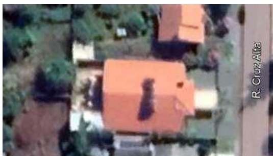
Figura 1 - Imagem da cobertura a ser instalado o sistema fotovoltaico.
