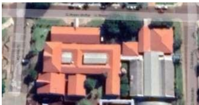
Figura 2- Imagem da cobertura a ser instalado o sistema fotovoltaico.
