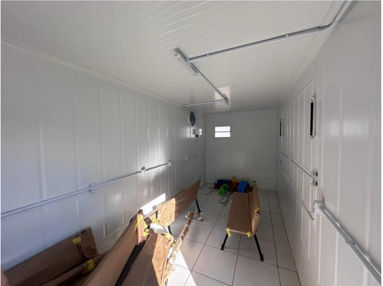
Fotografia 03 — Box 01/container: vista interna, com identificação da área de conveniência (12,99 m 2 ), instalações elétricas, esquadrias, janela de ventilação e infraestrutura existente.
