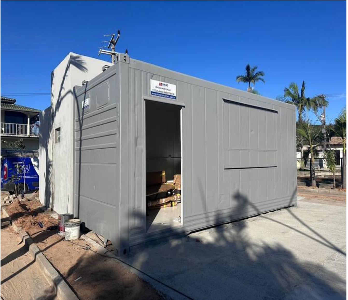
Fotografia 02 — Box 01/container instalado na Praça Pedro Bernardino da Silva: vista externa do bem público objeto da concessão onerosa de uso.
