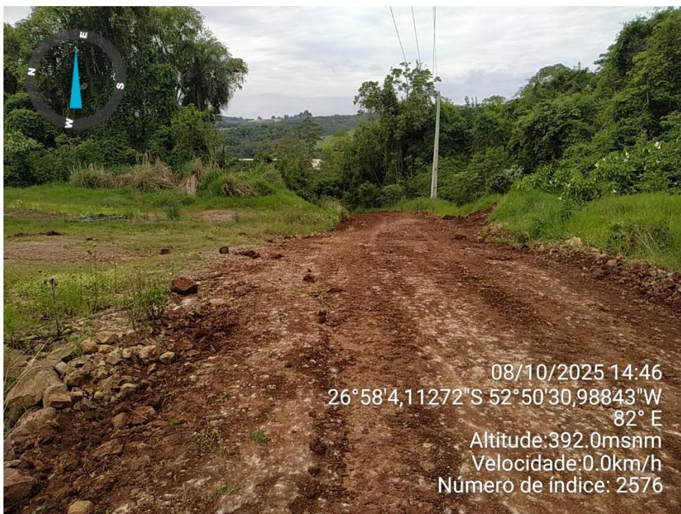
Foto 02: Início do trecho Estaca 1
