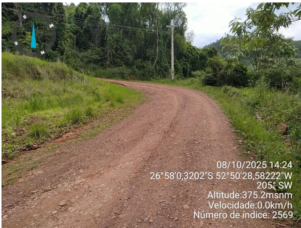
Foto 05: Final do trecho Estaca 8
