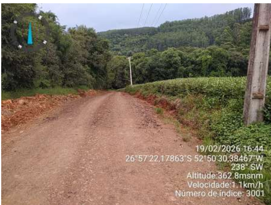
Foto 06: Final do trecho Estaca 10
