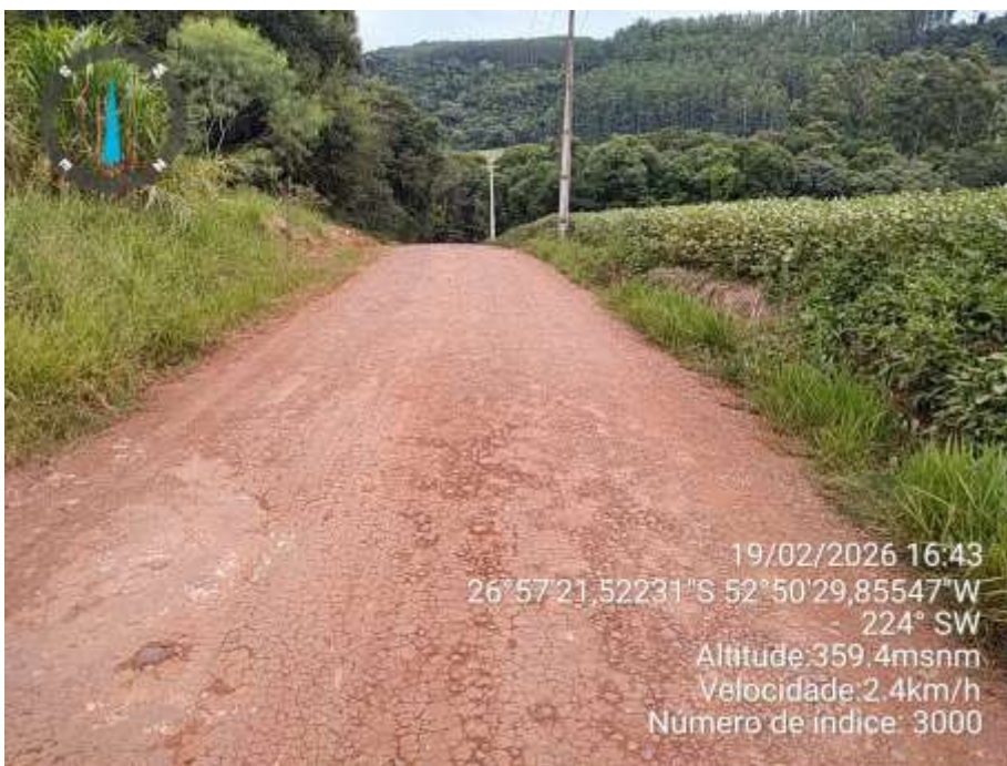
Foto 05: Final do trecho Estaca 9
