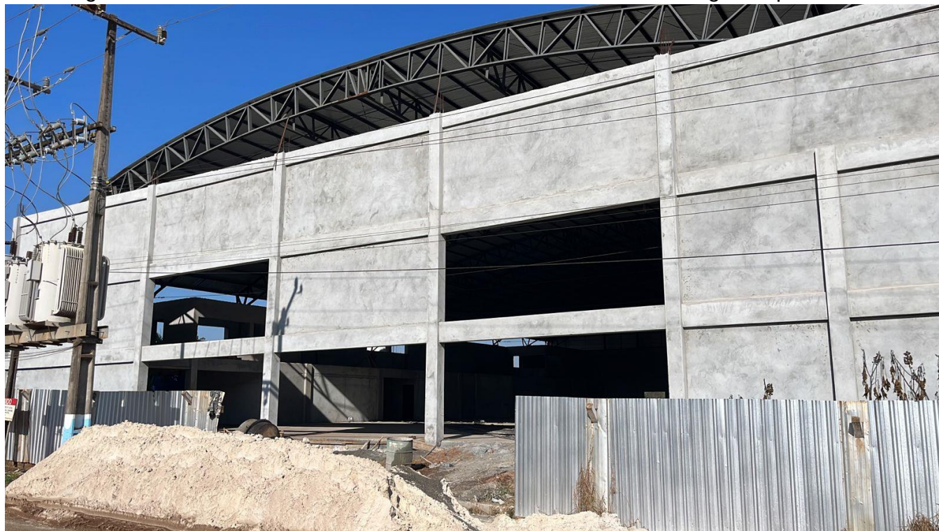
Figura 9 – Local de fechamento em alvenaria nos dois vão do segundo pavimento.
