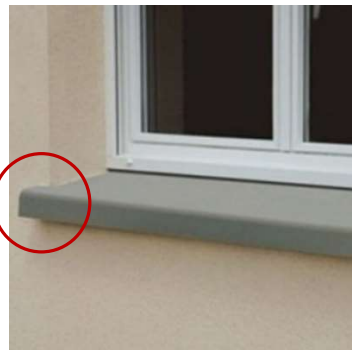
Figura 02 - Peitoril embutido 1 cm na alvenaria
