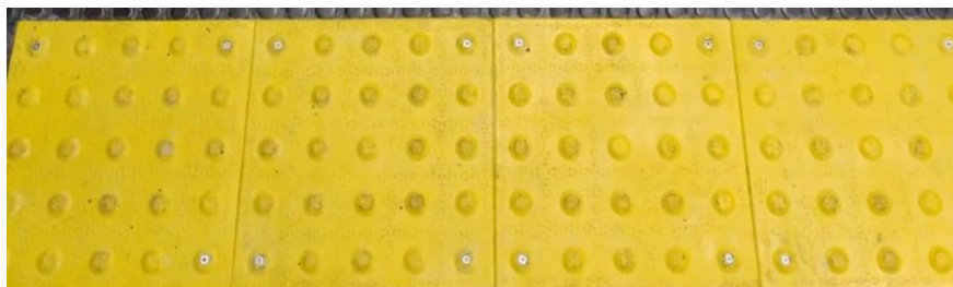
Exemplo de piso colado e parafusado
