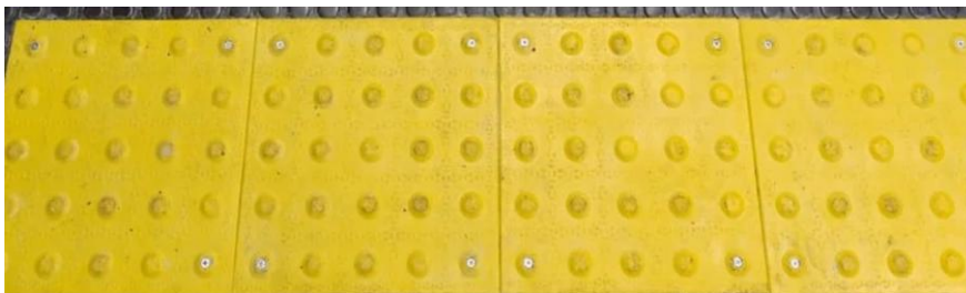
Exemplo de piso colado e parafusado
