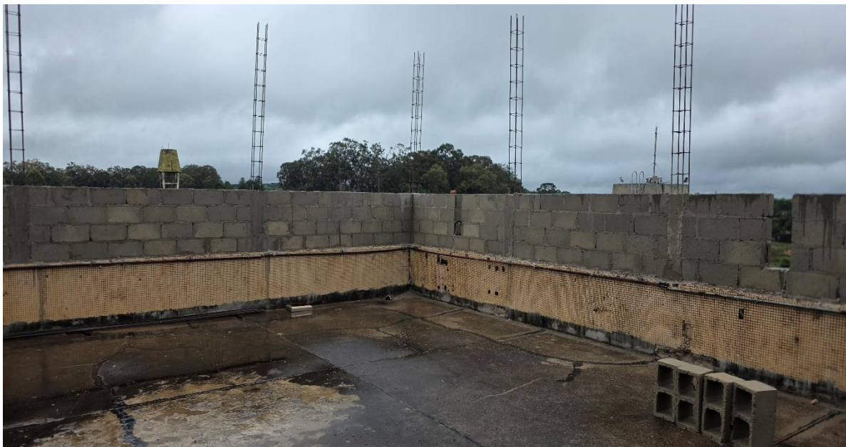
Foto 01: Vista da área da laje exposta a ser coberta com telha tipo sanduíche. Neste setor serão edificadas as salas de chefia, sala de armas, academia e copa, justificando a necessidade de isolamento termoacústico
