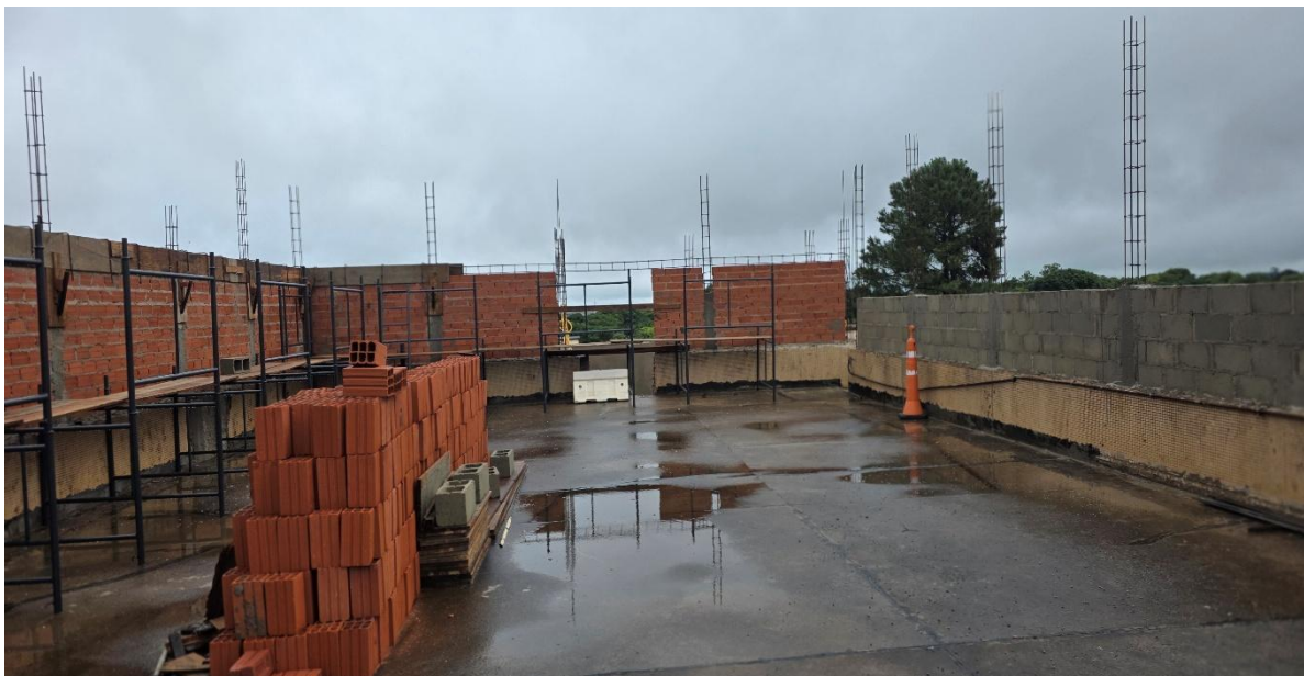
Foto 03: Vista do flanco esquerdo, destinado à construção dos banheiros masculino e feminino. A captação de águas pluviais será realizada por meio de dutos e condutores verticais em PVC.
