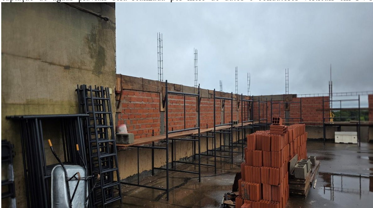
Foto 04: Detalhe do local de instalação da calha longitudinal, que fará a coleta das águas pluviais sendo direcionada para as duas pontas. A cobertura adotada será de uma água, com caimento de 5,00%
