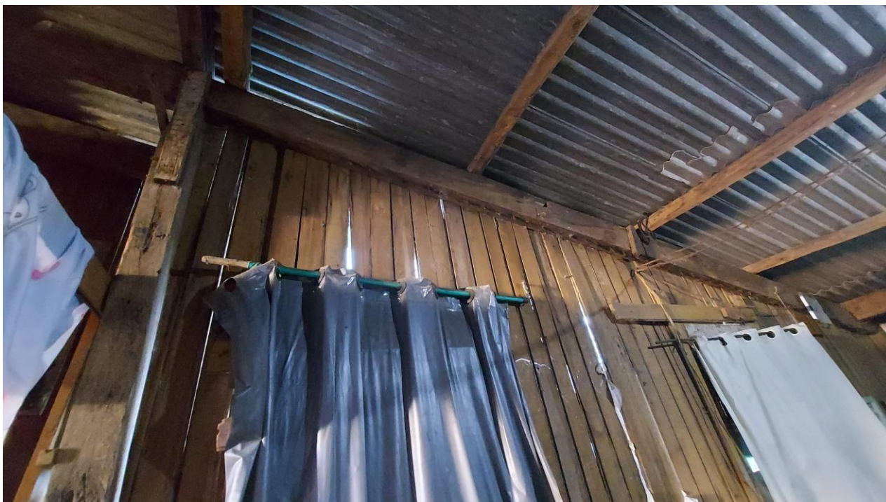
Figura 4: vista interna parede de madeira
