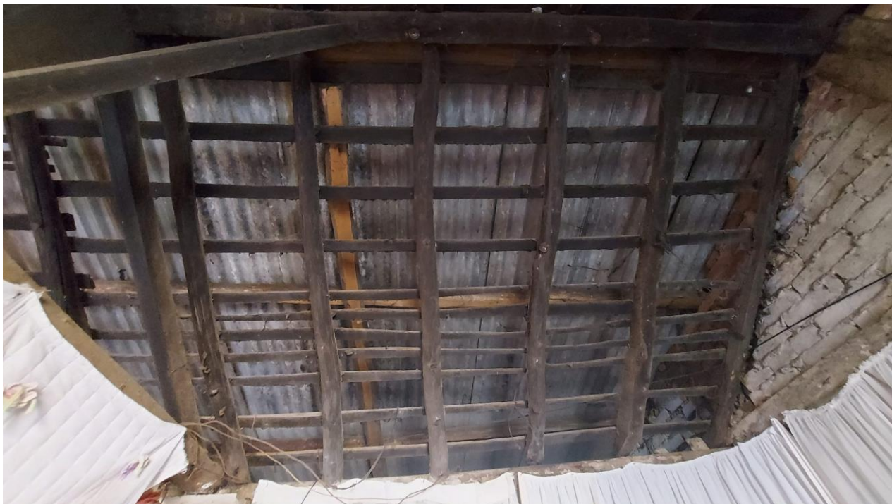
Figura 6: vista interna estrutura telhado residência
