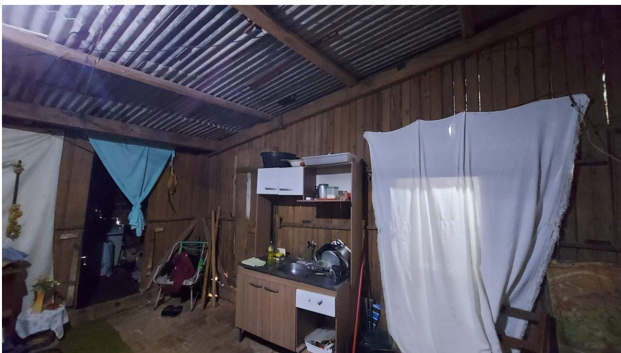
Figura 9: vista interna parede madeira residência
