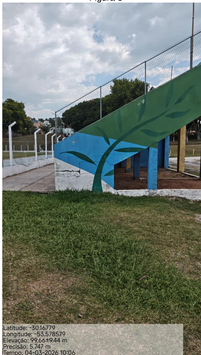
Local de instalação do bicicletário
