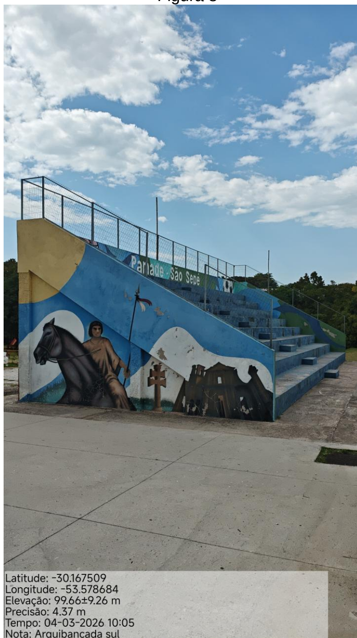
Instalação de cobertura – Arquibancada Sul
