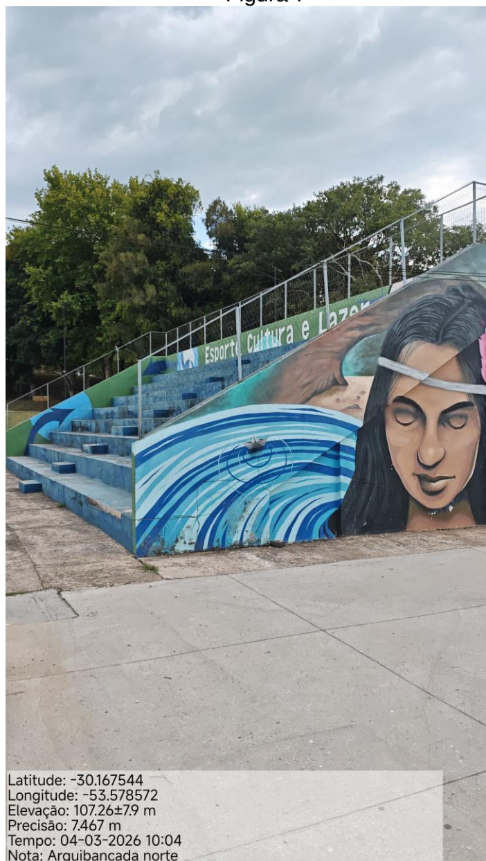
Instalação de cobertura – Arquibancada norte
