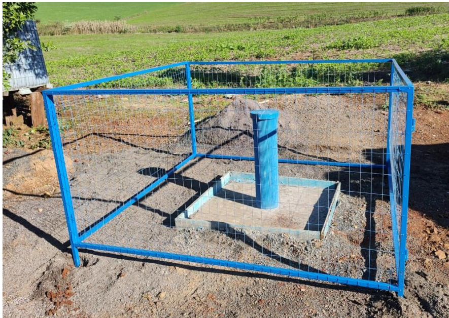
Figura 7 Poço concluído. Fonte: Autor.
