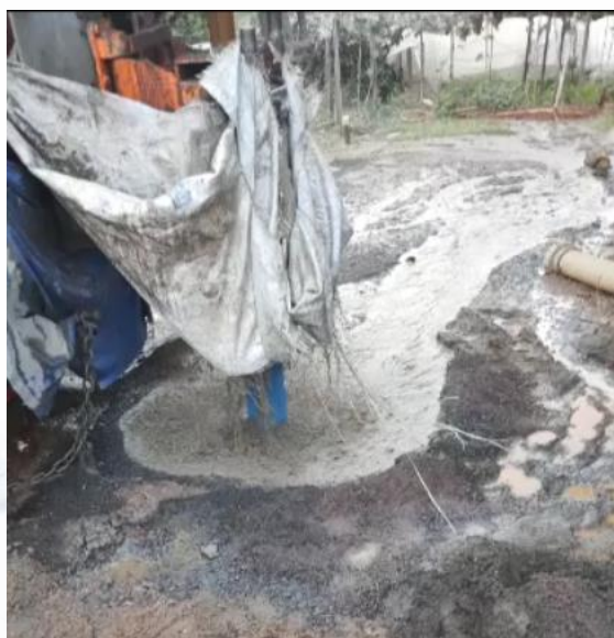
Figura 4 Foto da obra de perfuração do poço. Fonte: Autor.
