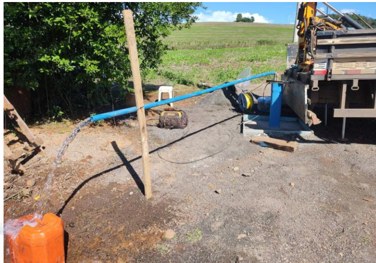
Figura 5 Realização do teste de vazão. Fonte: Autor.
