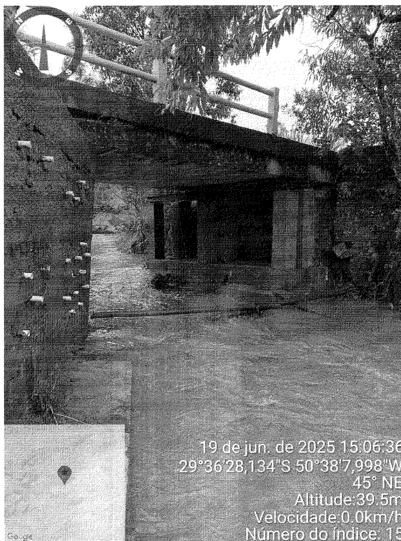
Imagem 02: Apresentação da Ponte de Açoita Cavallo, relato em 19 de junho de 2025.
