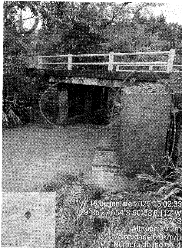
Imagem 03: Demonstração do reforço estrutural.
