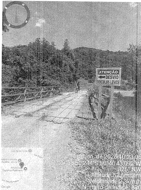
Figura 3 – Localização da Ponte na Rua da Comunidade, Distrito de Padilha.
