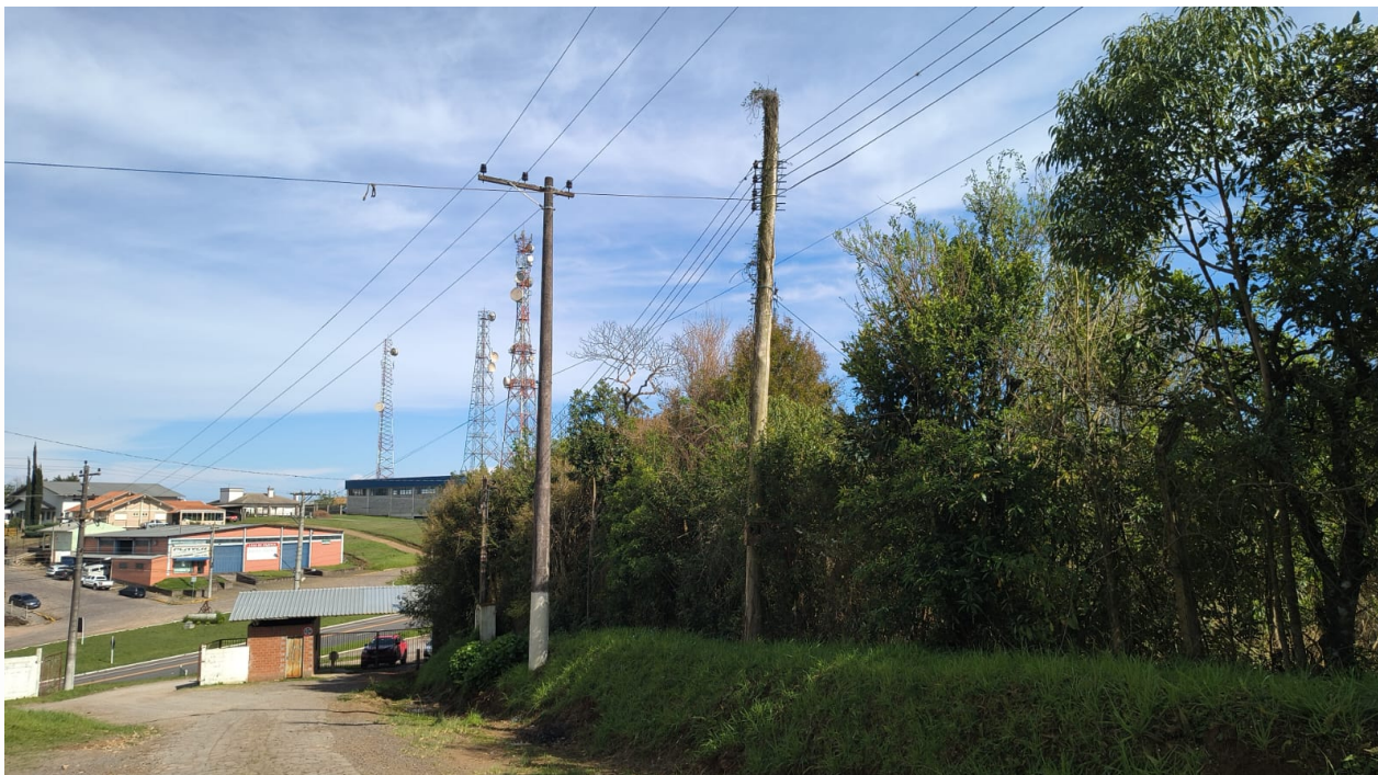
Imagem da localização do poste de madeira e de concreto no CTG. (Fonte: Prefeitura Municipal de Veranópolis) – 19/09/2025.
