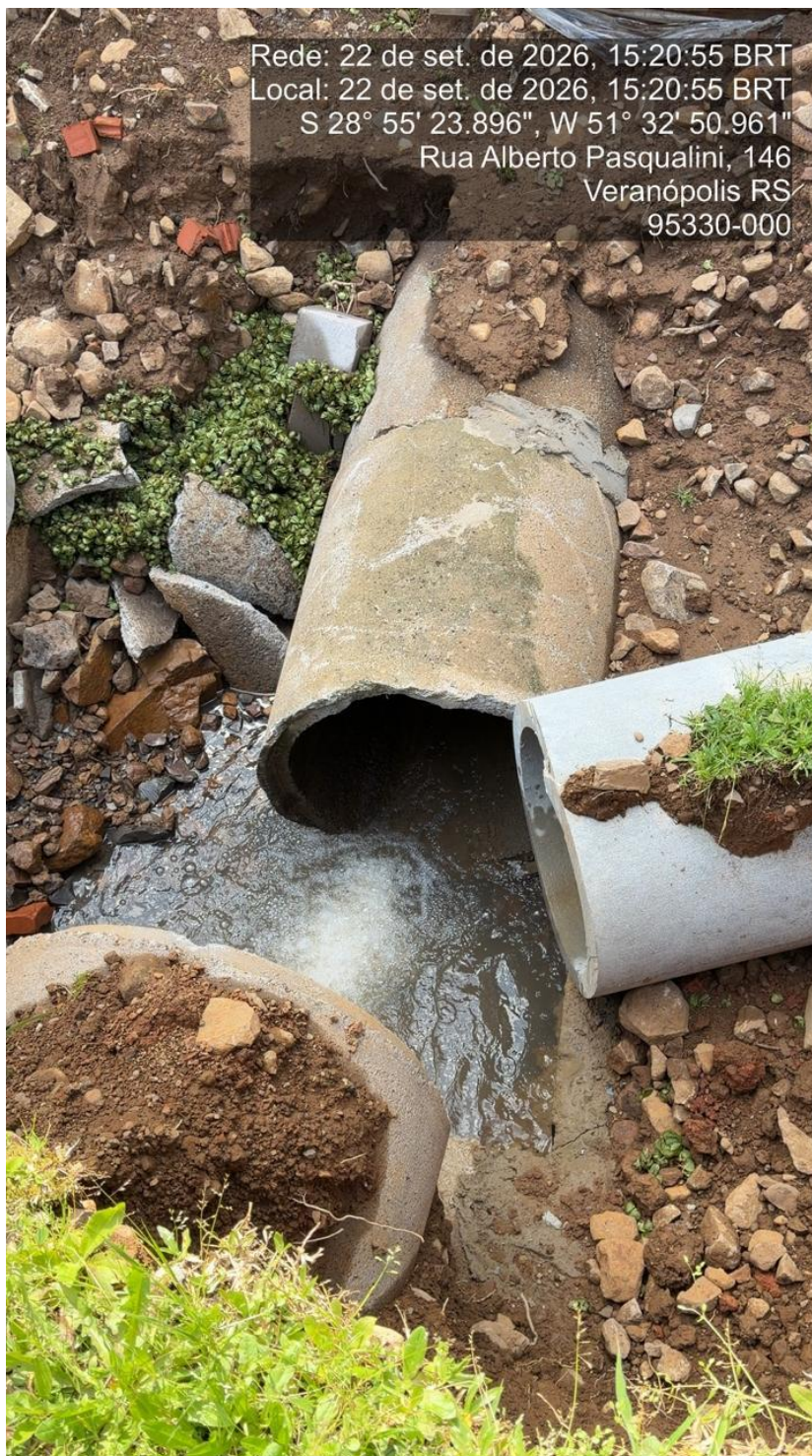
Imagem 13 - prejuízos causados da entrada de algas na tubulação existente – rompimento de tubulação
